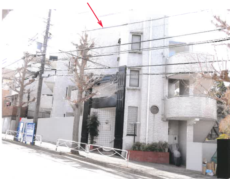
① 建物の外観（北東側から撮影）
