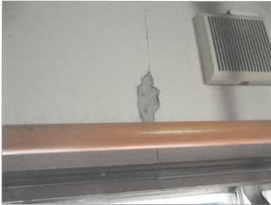
⑦上部を撮影
