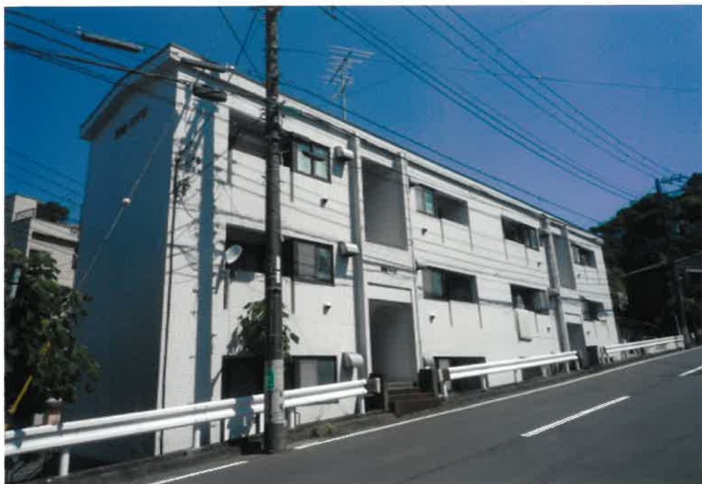
1 物件 1 ～ 3 建物の外観
