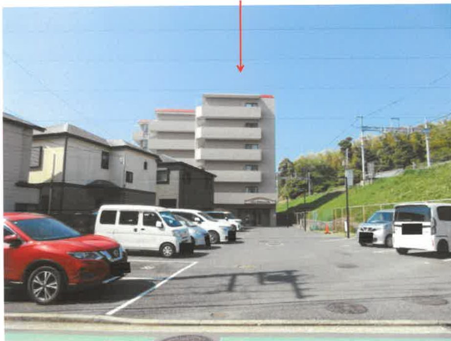
物件 1 の存する一棟の建物
