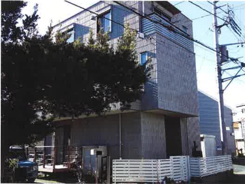
①物件3の建物の外観
