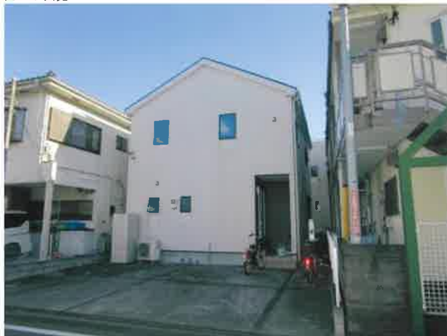
① 建物の外観
