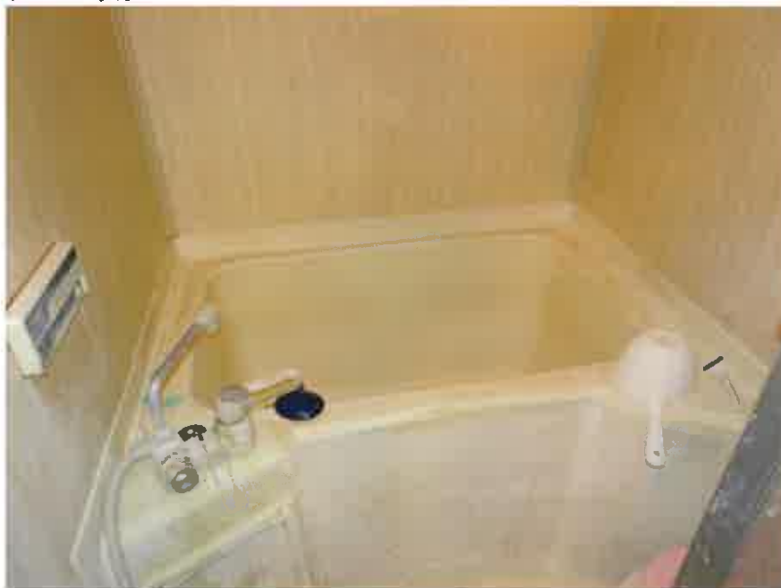
④ 建物内の状況
