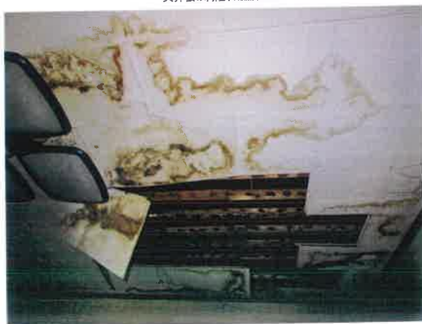
天井板の剥離、雨漏りの跡
