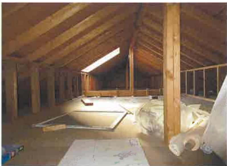
⑫ 小屋裏部分
