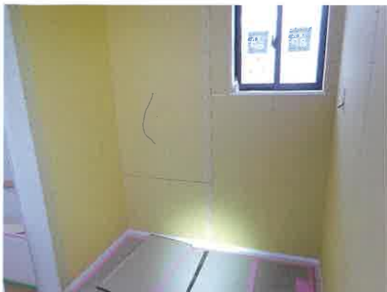
1 階（洗面室部分）⑦
