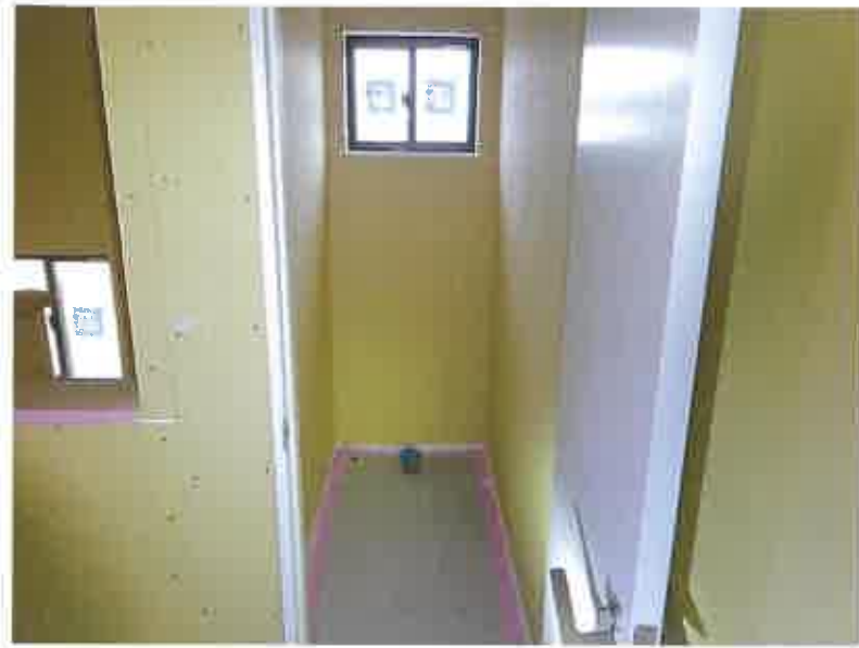
2階（トイレ部分）⑬
