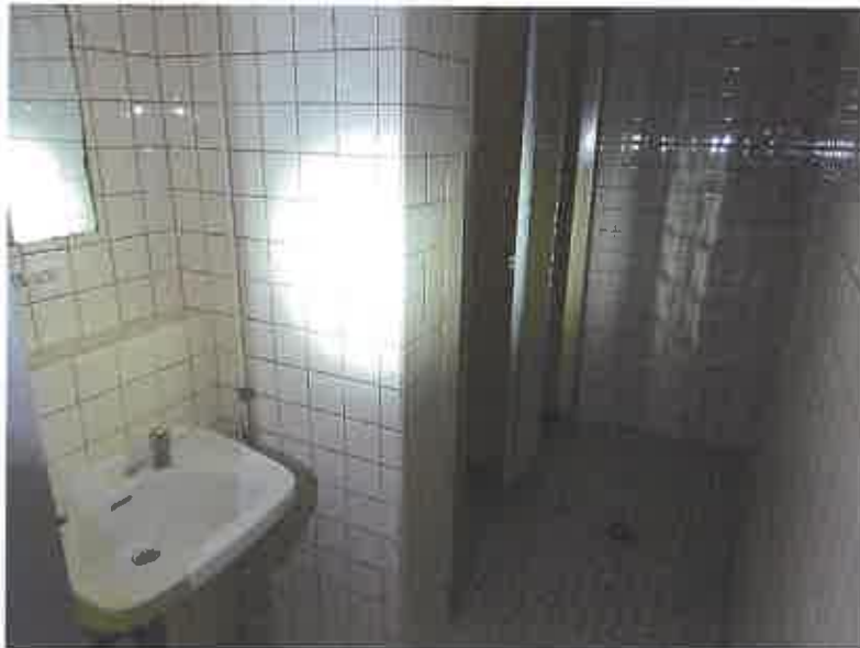
物件1の建物（1階（南側）トイレ）⑭
