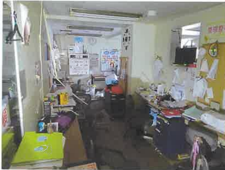
物件1の建物（1階（事務室））⑧
