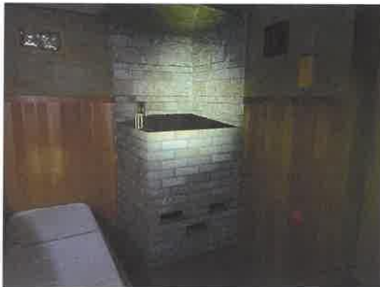
物件1の建物（2階（南側）更衣室内トイレ）㊹
