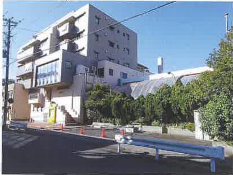
物件 1 の建物（1 階（プール））②
