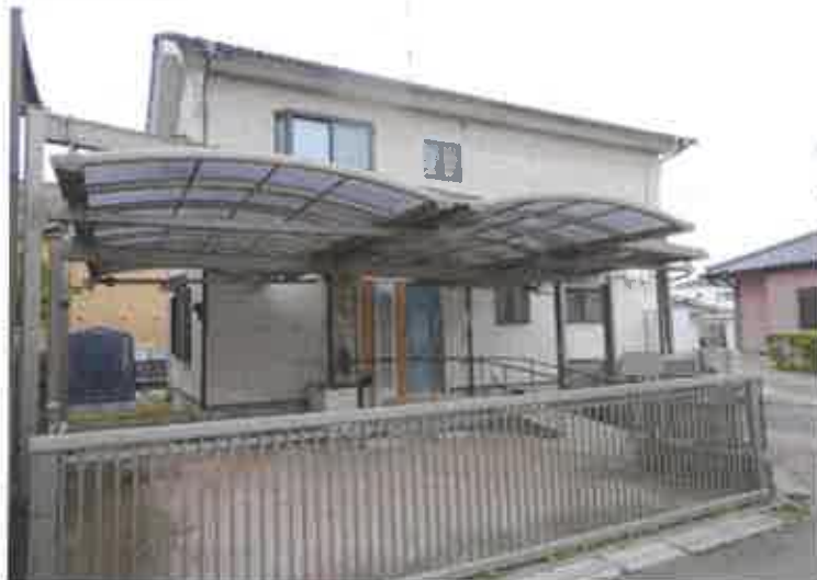
① 建物の外観
