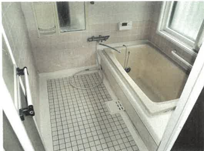
物件2 1階 浴室の状況 ⑧
