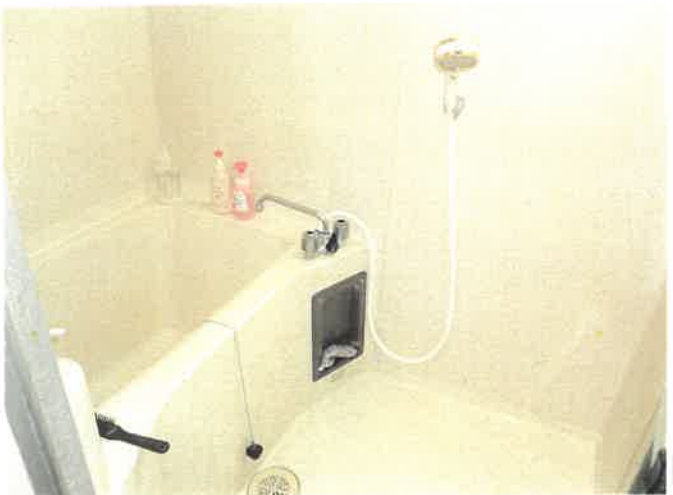
308号室 浴室の状況 ⑥6
