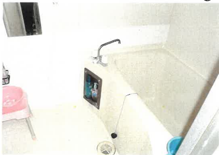
301号室 浴室の状況 ④⑤
