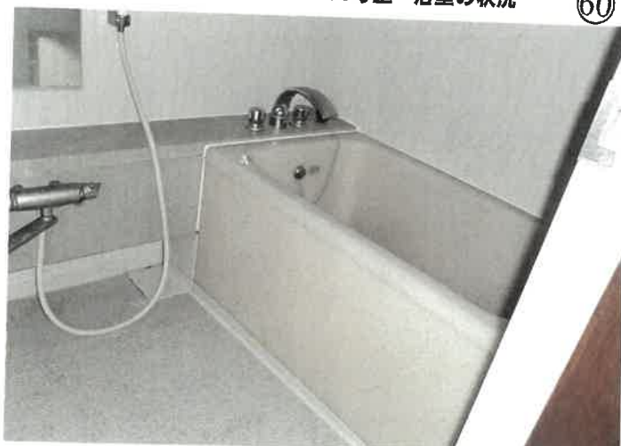
306号室 浴室の状況
