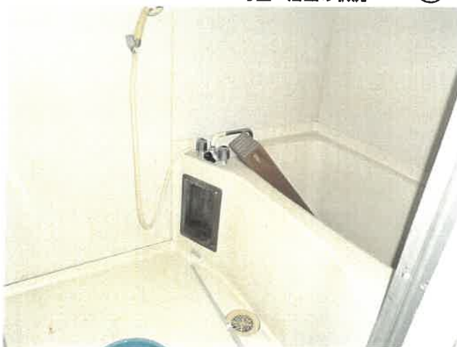
501号室 浴室の状況 ⑨⑦
