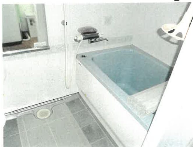
502号室 浴室の状況 ⑩①
