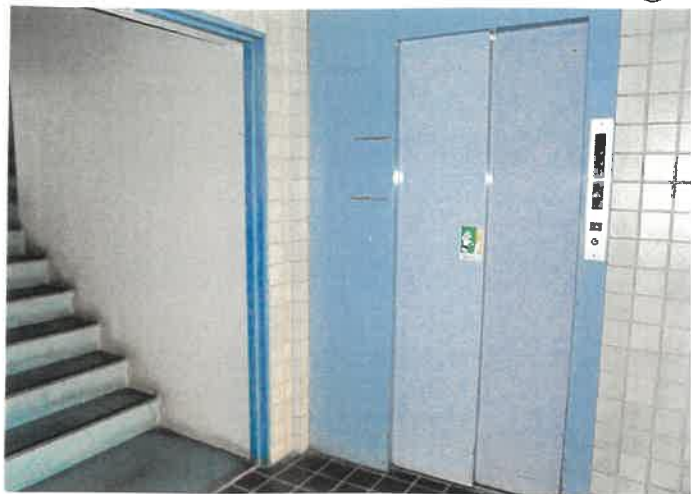
物件4 1階 エレベーターホールの状況 ⑭
