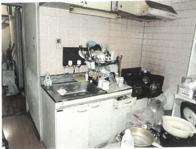
207号室 ダイニング・キッチン③⑤の状況
