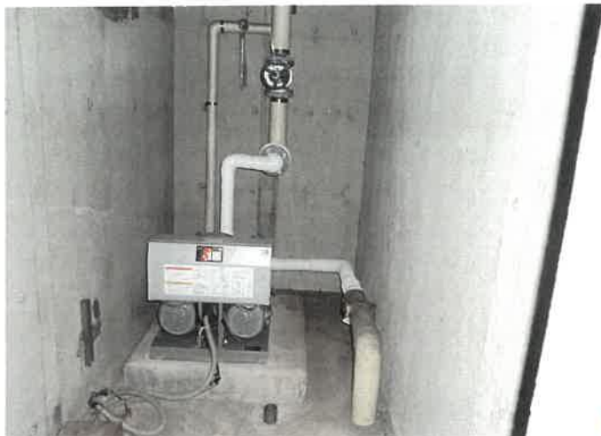
物件4 1階 ポンプ室の状況 ⑪
