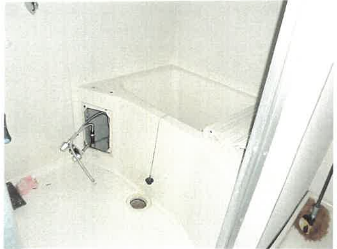
307号室 浴室の状況 ⑥3
