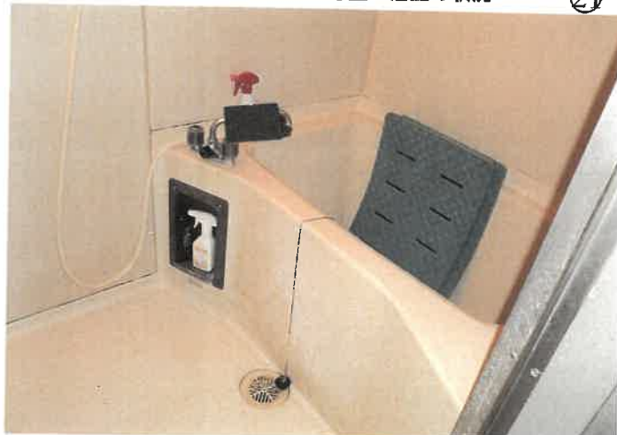
201号室 浴室の状況 ⑮
