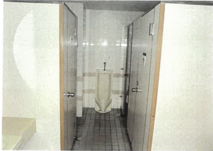
物件4 1階 トイレの状況 ⑫
