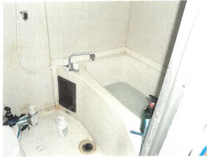
207号室 浴室③⑥の状況
