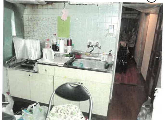
208号室 ダイニング・キッチン③⑧の状況
