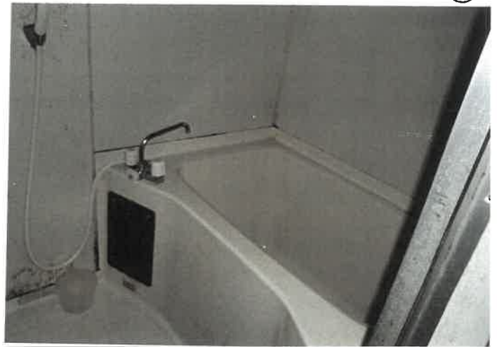
205号室 浴室の状況 ③0
