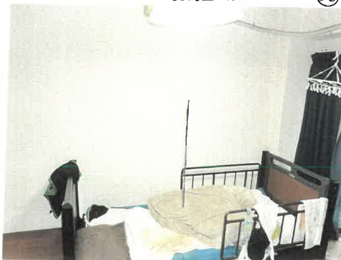
501号室 洋室の状況 ⑨⑤
