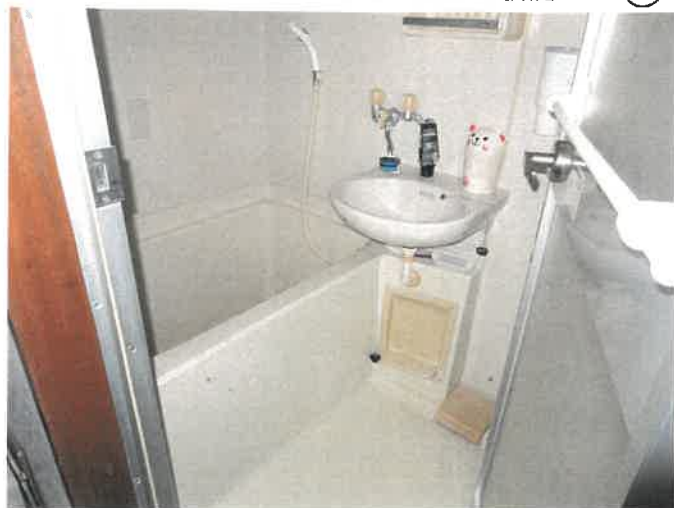
物件4 4階402号室 浴室の状況 ③④
