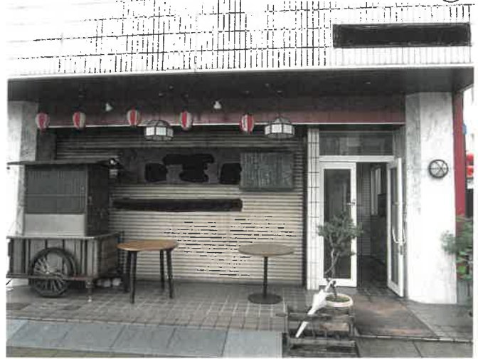
物件4 1階東側部分の状況 ⑧
