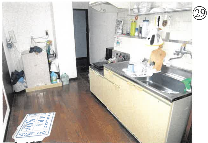
物件4 4階401号室 キッチンの状況
