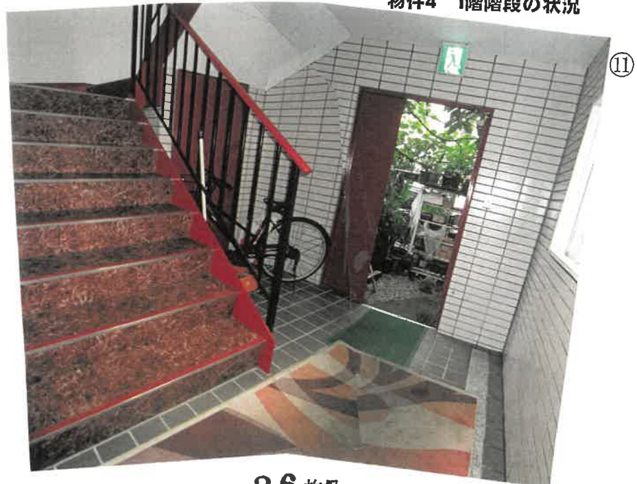
物件4 1階階段の状況
