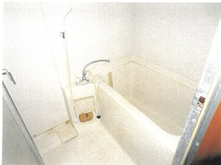
物件3 1階 浴室の状況
