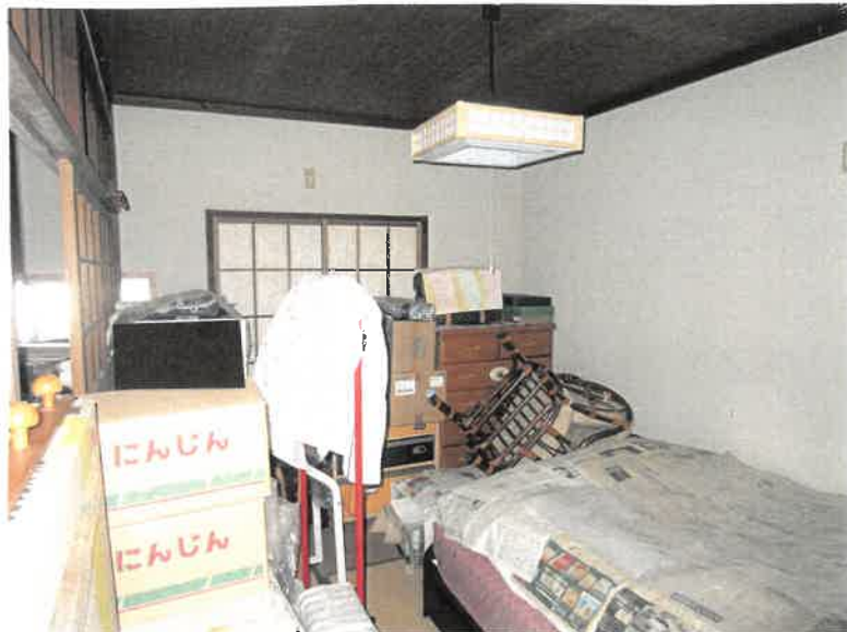
物件3 2階 和室の状況
