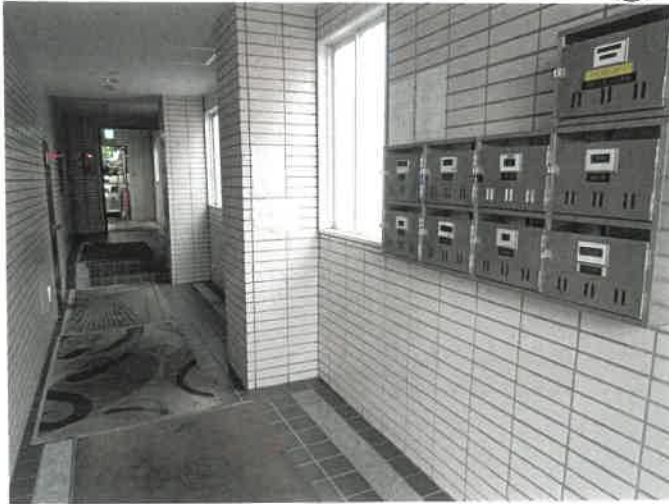
物件4 1階ホールの状況 ⑨
