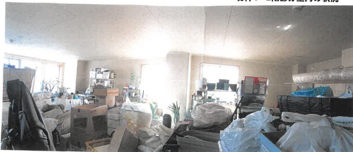
物件4 2階部分室内の状況
