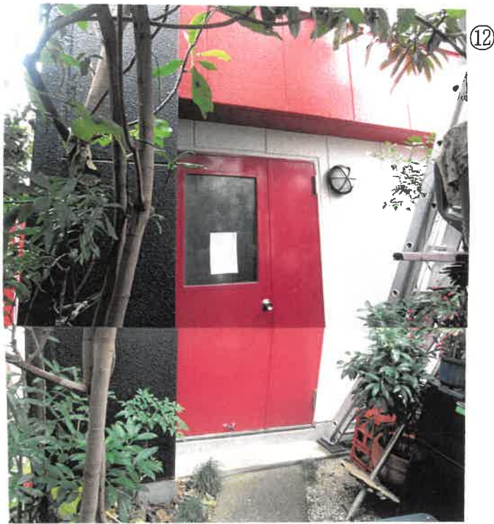
物件4 1階西側部分の状況
