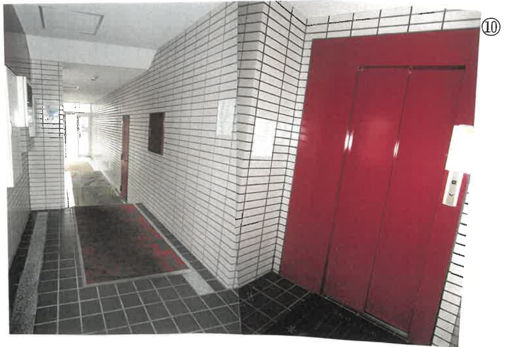
物件4 1階エレベーターホールの状況
