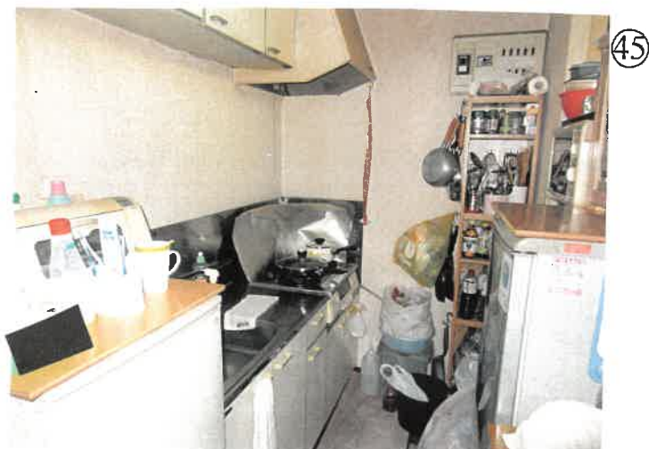
物件3 1階 キッチンの状況
