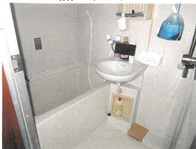
物件4 3階302号室 浴室の状況
