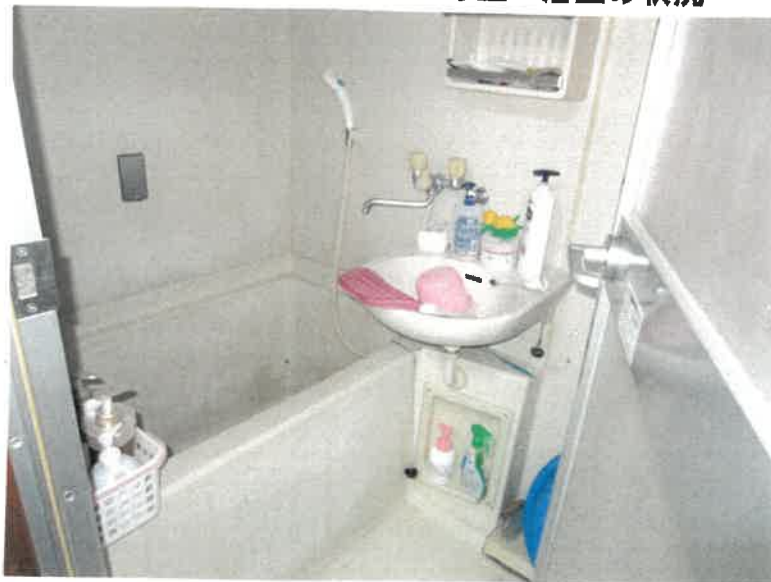
物件4 5階501号室 浴室の状況
