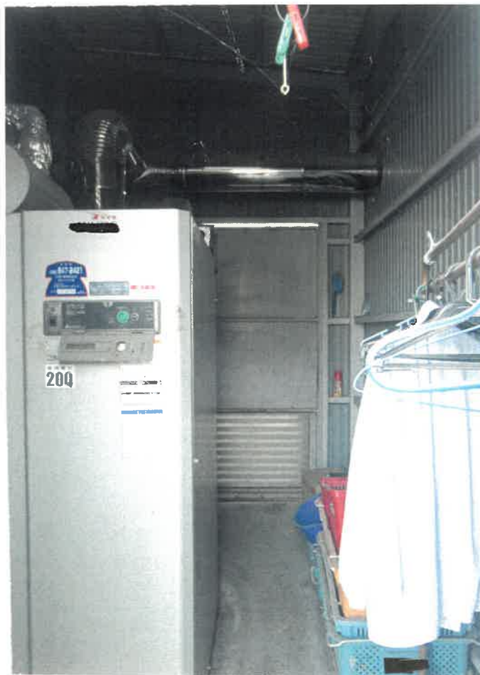
物件5未登記附属建物 ボイラー室の状況
