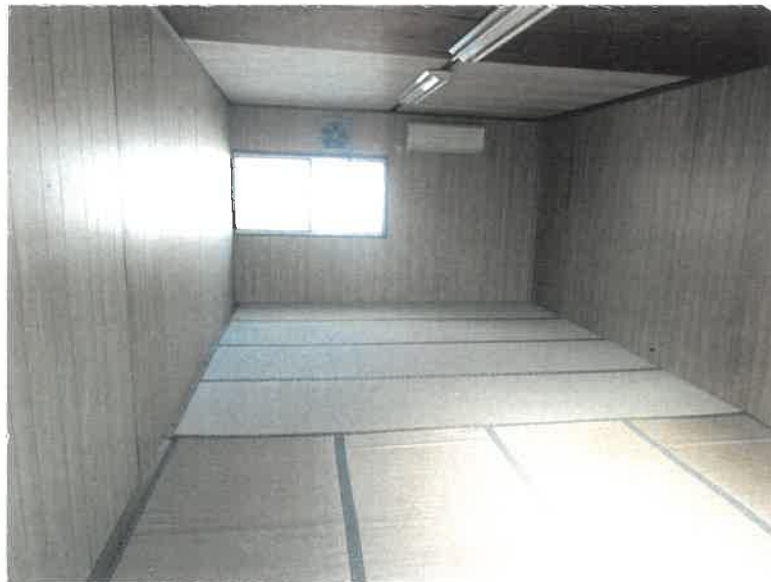
物件5附属建物符号1 2階 休憩室の状況
