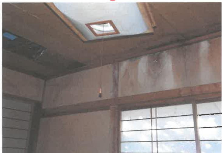
和室の天井の状況
