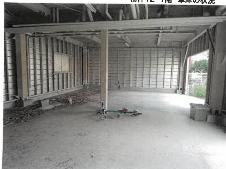
物件12 1階 車庫の状況
