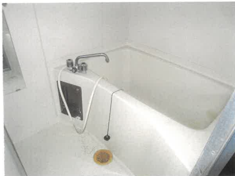
物件12 2階 南側居室 浴室の状況
