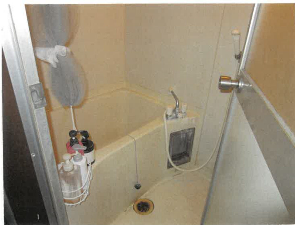
物件12 2階 北側居室 浴室状況
