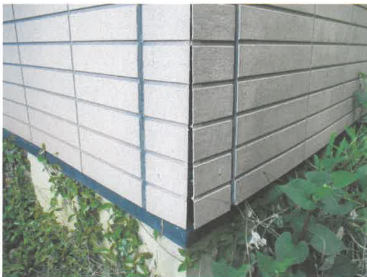
写真9 (外壁が剥離している箇所)
