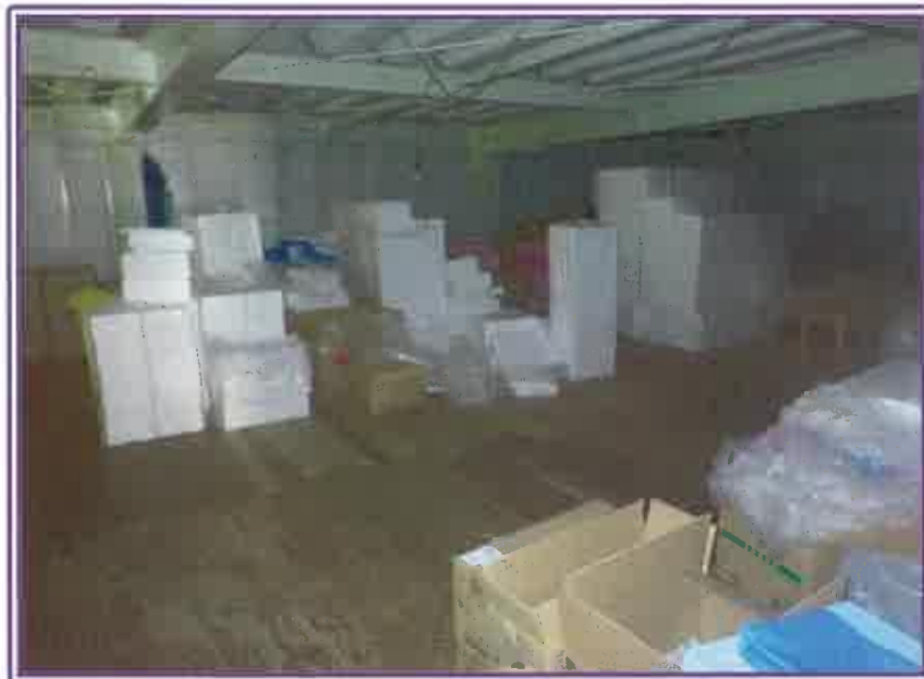
冷蔵庫・冷凍庫上部のスペース
