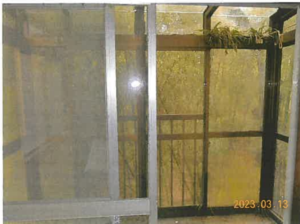
写真 1 5 本件建物 2 階洋室南側部分のサンルーム
