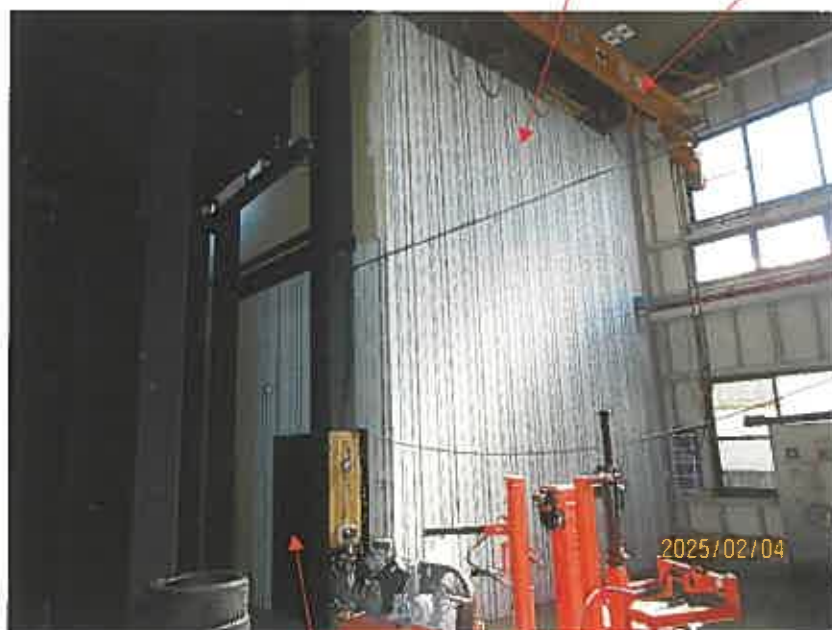
増築部分出入口
