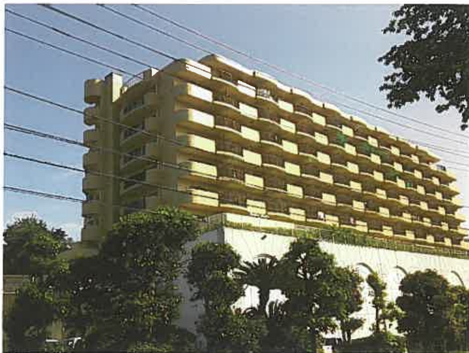
写真2 一棟の建物及び敷地内駐車場の一部
