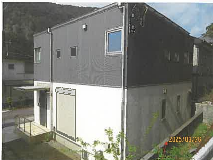
コンクリート擁壁
