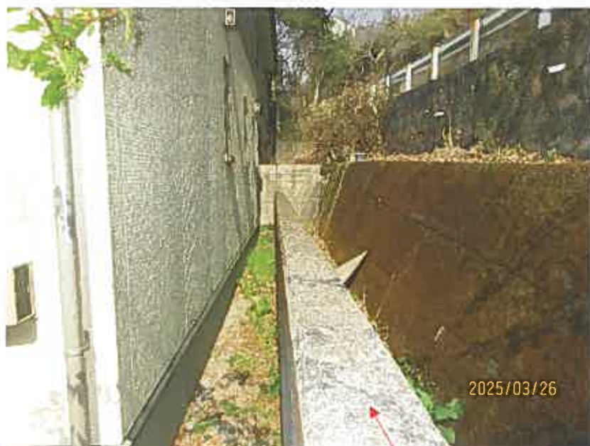
コンクリート擁壁
