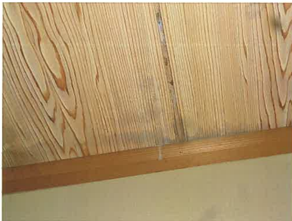
写真 1 8 2階南東側和室天井の雨漏り跡
