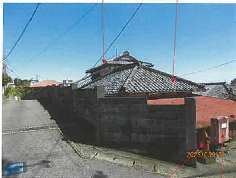
消火栓 消火用ホース収納庫
