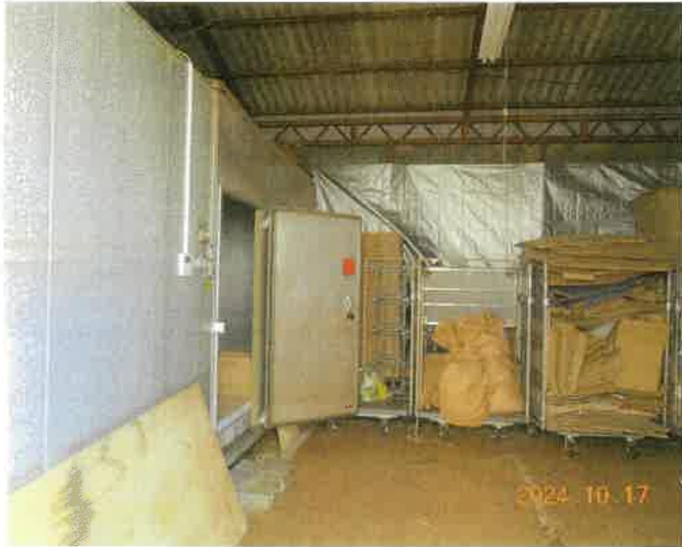
写真 2 9 物件 6 附属建物符号 1 の冷蔵倉庫
