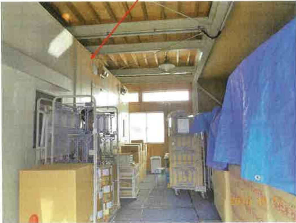
写真 2 3 物件 6 の建物内 クリーンルーム
