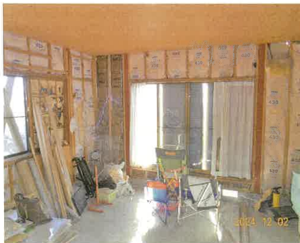
写真 1 6 本件建物 1 階和室を土間にリフォームしている箇所
