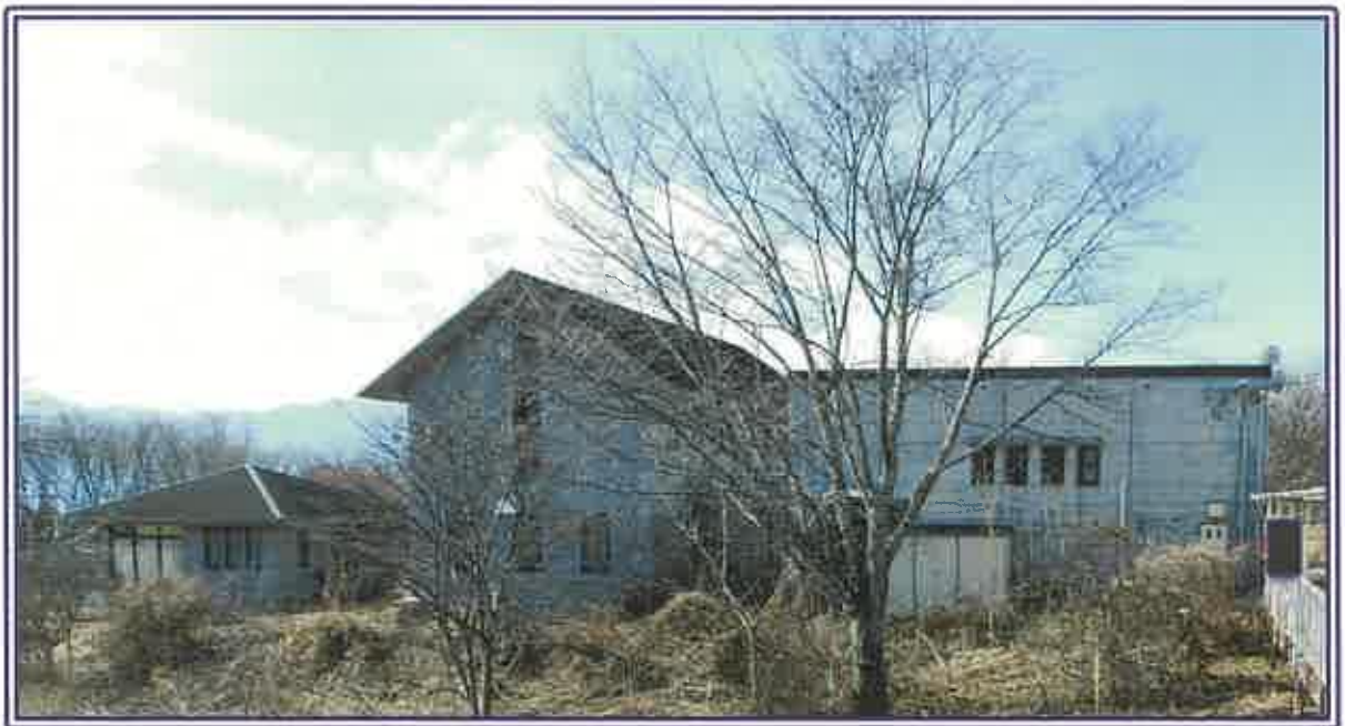
本件建物の東側近景（左の平家建が附属建物・右の2階建が主たる建物）
