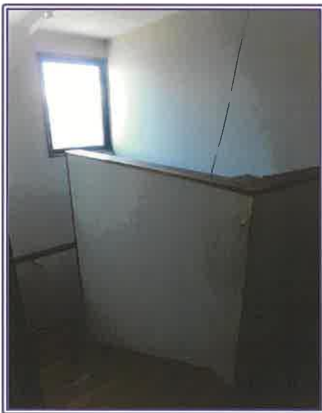
2階 階段（主たる建物）
