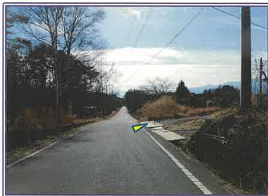
東側で隣接する公道の状況
