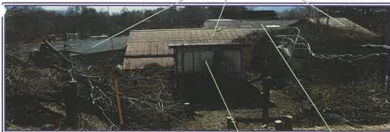
売却対象外建物である工場群の全景（工場群の敷地の大方は 物件6の土地）
