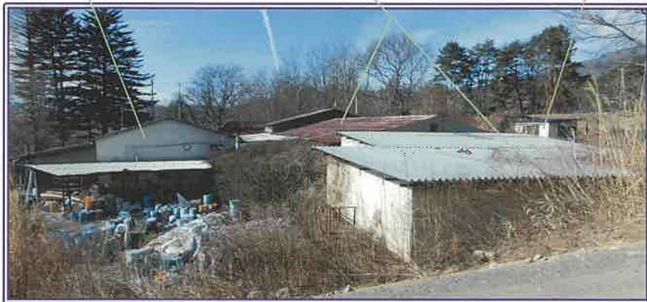
売却対象外建物である工場群の全景（工場群の敷地の大方は 物件6の土地）
