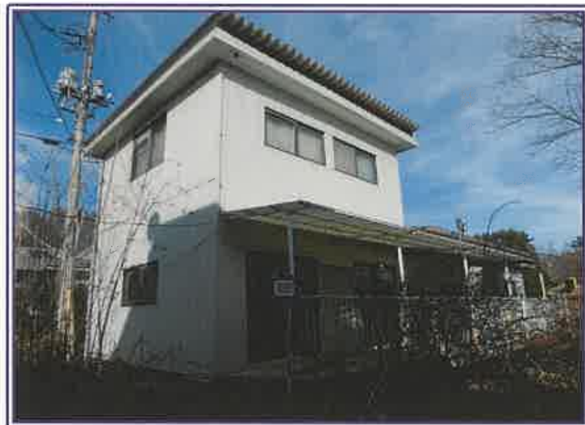
売却対象外建物である居宅（目的外建物2）の近景（敷地の大方は 物件17の土地）
