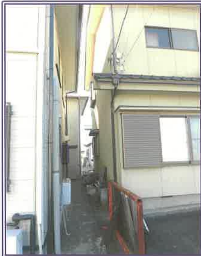
隣宅との近接状況
