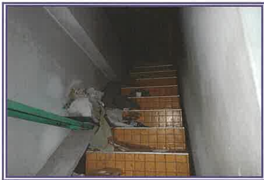
1階から、階段方向を撮影したもの
