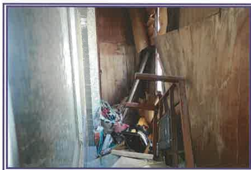
東側増築部分を撮影したもの(2階)
