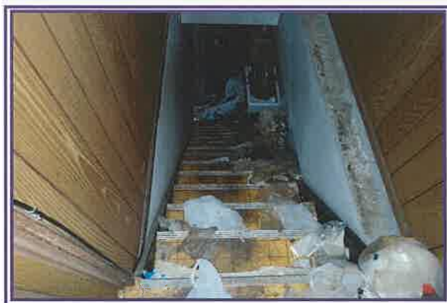
2階から、階段方向を撮影したもの
