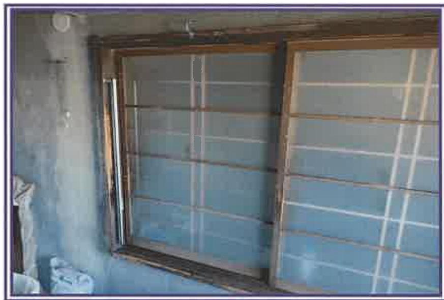
物件4の建物内から、物件2の建物との結合部方向を撮影したもの
