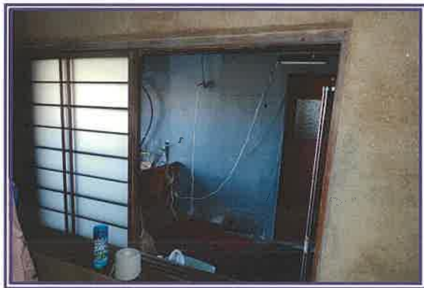
物件2の建物内から、物件4の建物との結合部方向を撮影したもの
