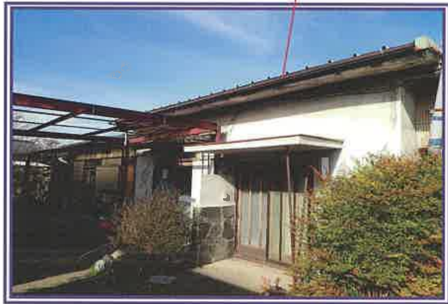
玄関付近を撮影したもの
