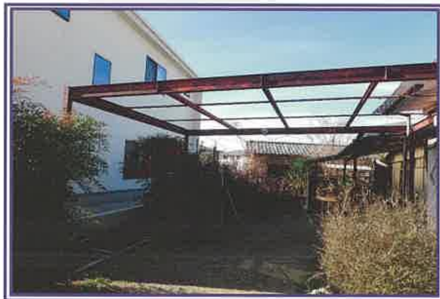
鉄骨造の構築物を撮影したもの
