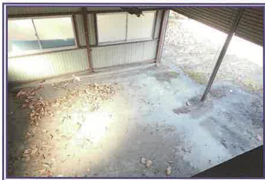
ロフト部分から1階方向を撮影したもの(物件3附属建物符号1)
