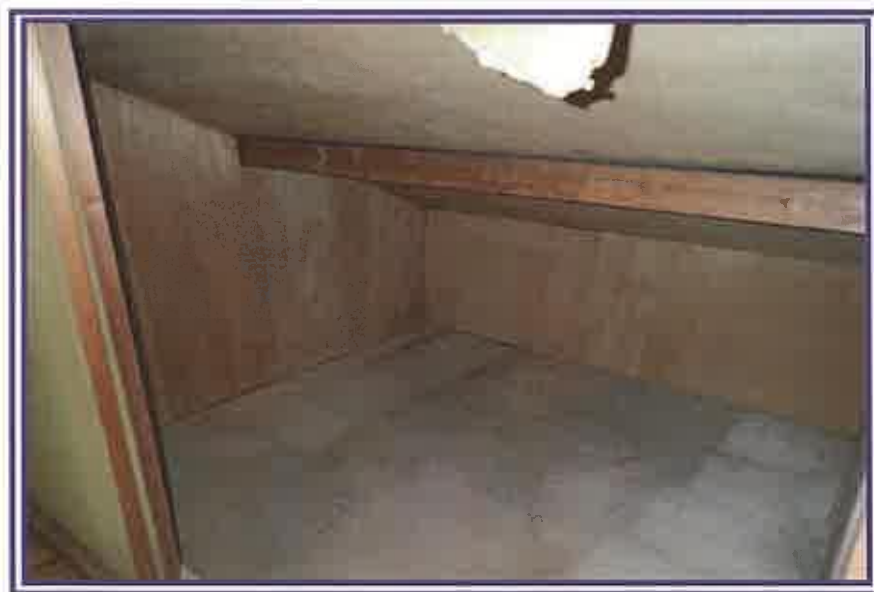
屋根裏(物件3主である建物)
