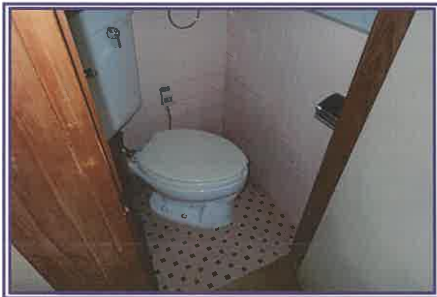
2階トイレ(物件3主である建物)
