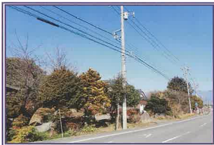
物件2の土地上に電柱が設置されている状況を撮影したもの
