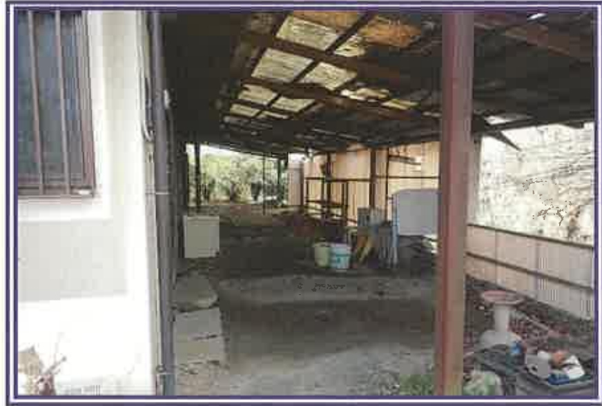
物件3(居宅)の下屋を撮影したもの
