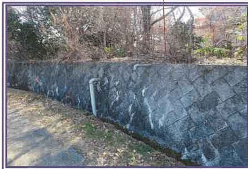
北側隣地(地番595番2)の地下に、排水管が埋設されている状況を撮影したもの
