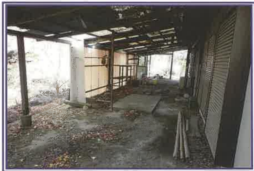
物件3(居宅)の下屋を撮影したもの
