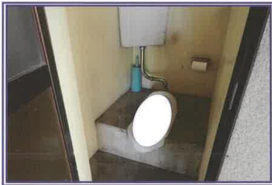
1階トイレ2(物件3主である建物)
