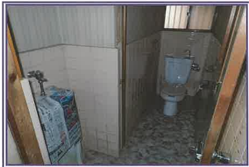
1階トイレ1(物件3主である建物)
