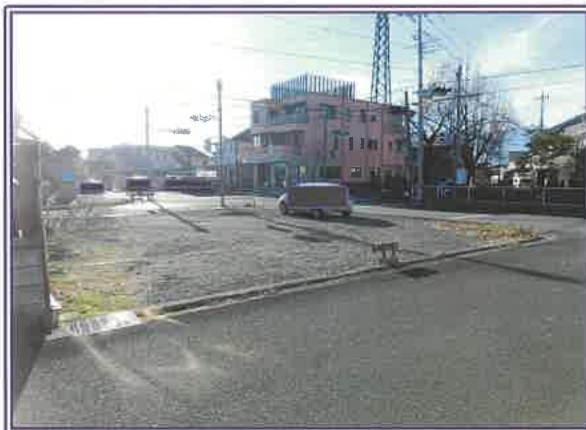
当マンション居住者用の駐車場の状況（砂利敷の物件4の土地）
