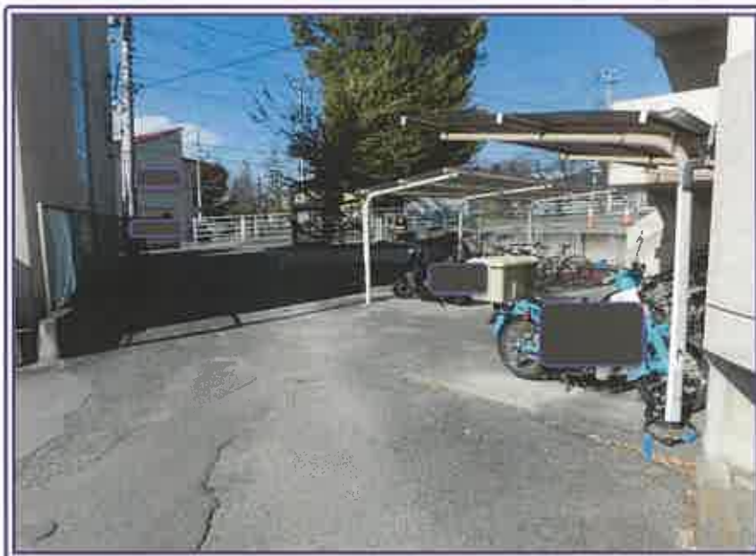
敷地内の状況
