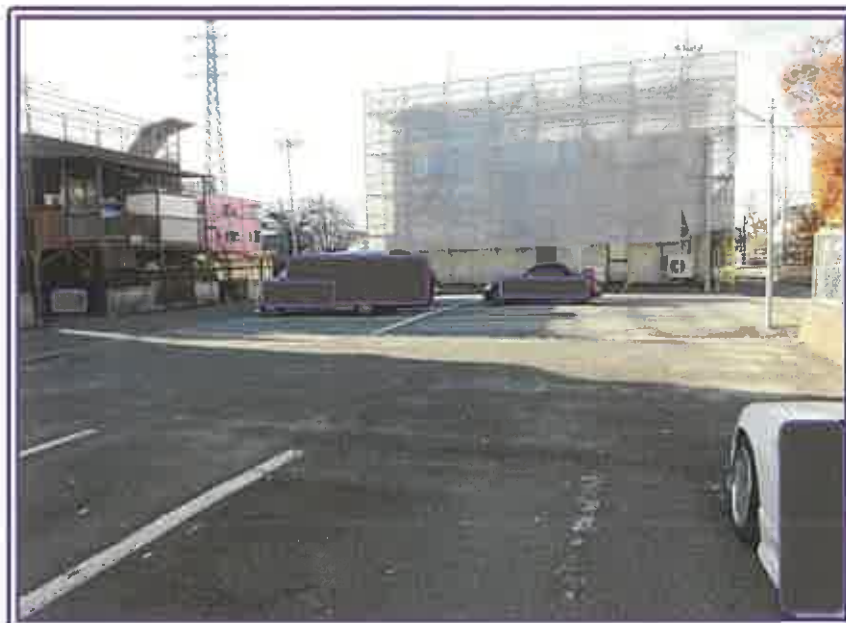
当マンション居住者用の駐車場の状況（手前が物件3の土地）
