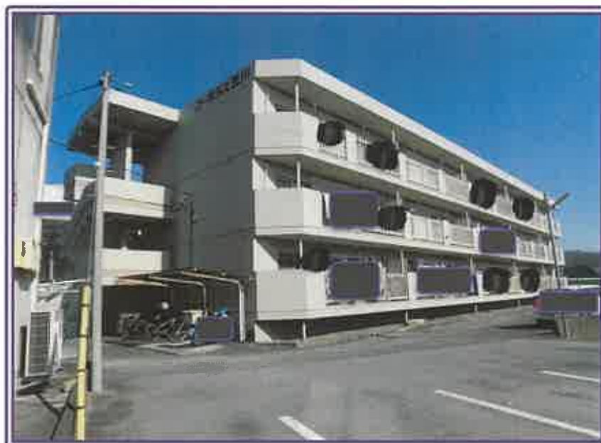
売却対象の共同住宅のバルコニー側近景
