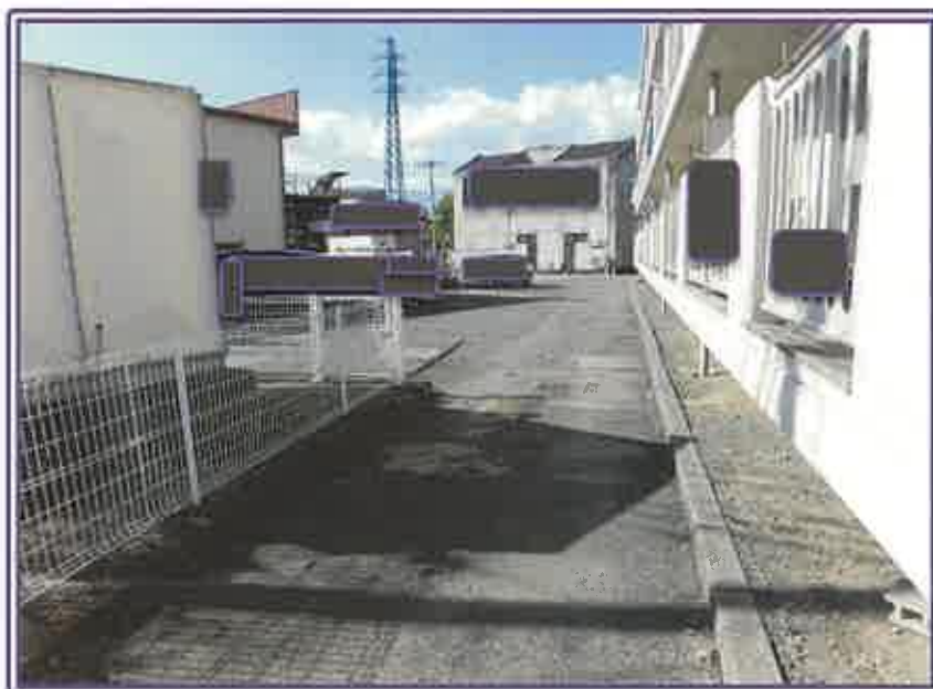
敷地内の状況
