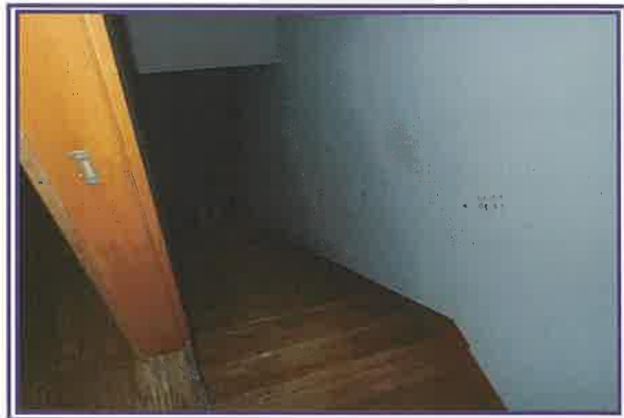
2階から、階段方向を撮影したもの
