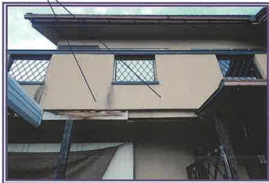
ベランダの亀裂の補修箇所を撮影したもの
