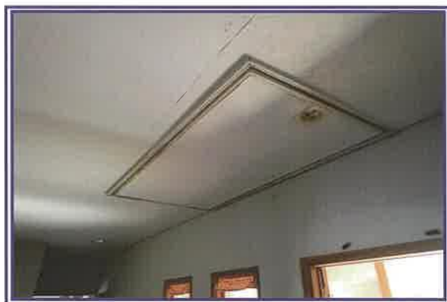
屋根裏への梯子付近(格納時)を撮影したもの
