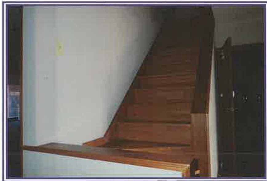
1階から、階段方向を撮影したもの
