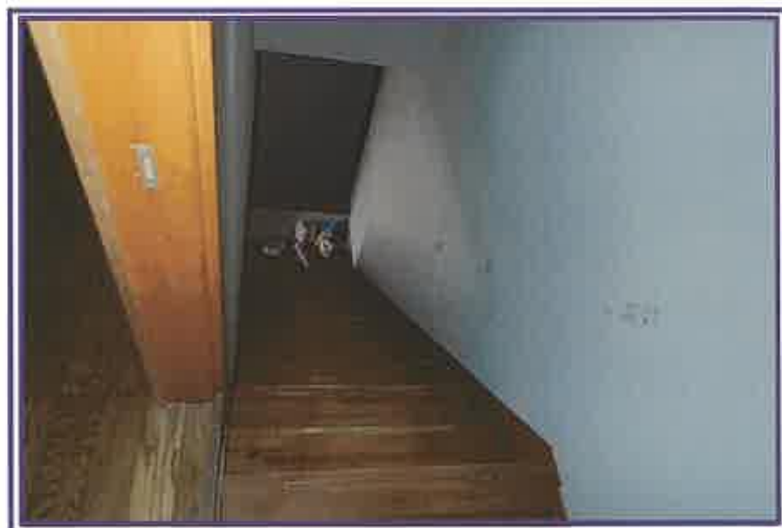
2階から、階段方向を撮影したもの
