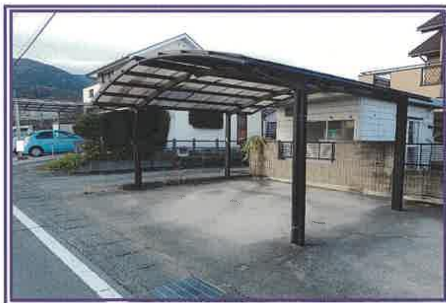
カーポート及びその周辺を撮影したもの
