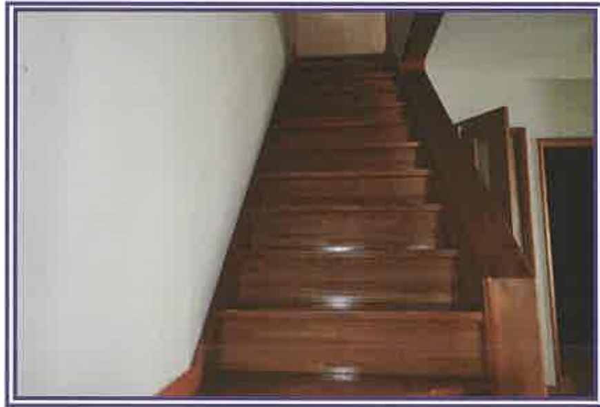
1階から、階段方向を撮影したもの
