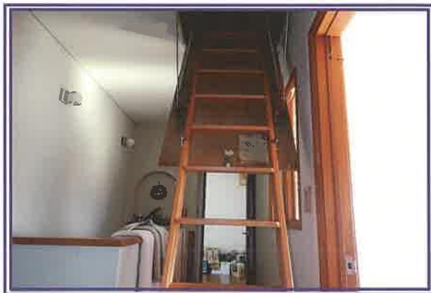
屋根裏への梯子付近を撮影したもの
