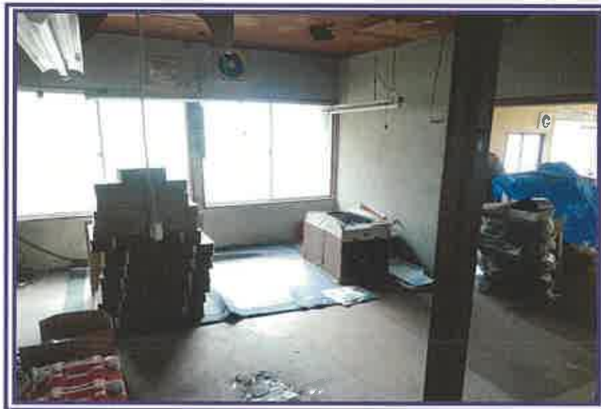
作業所(北側) (物件4主である建物)
