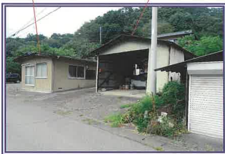
物件4附属建物 符号1(車庫)
