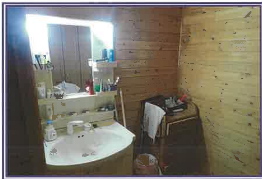
洗面台 (物件3(居宅))
