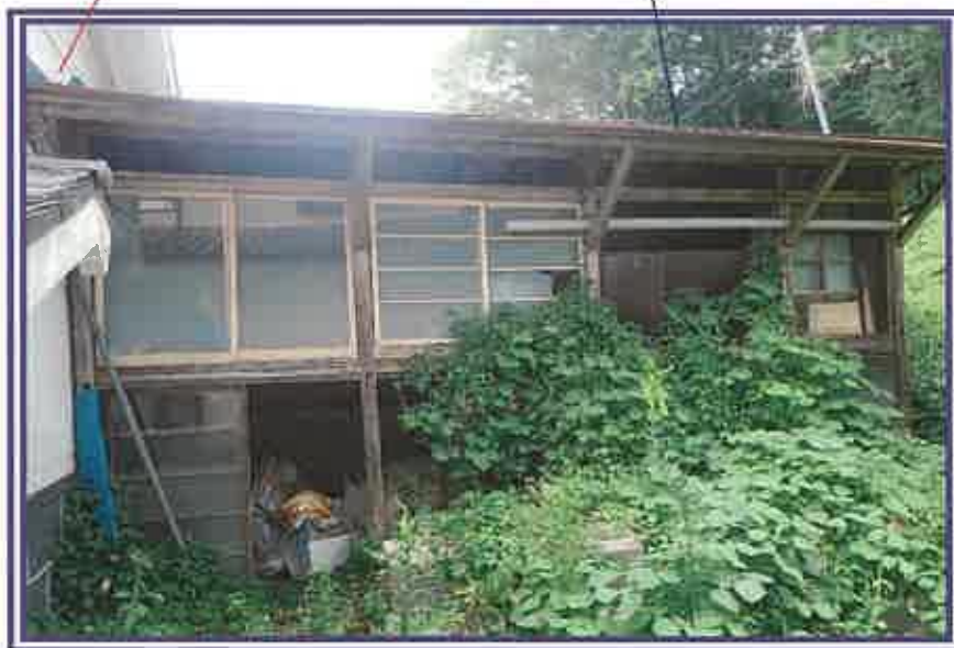
物件2未登記 附属建物(倉庫)
