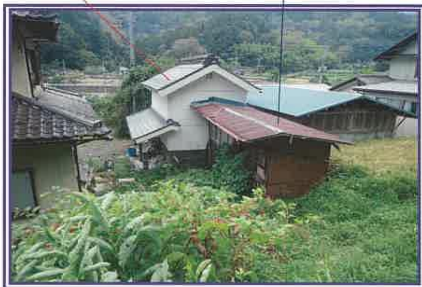
物件2未登記 附属建物(倉庫)
