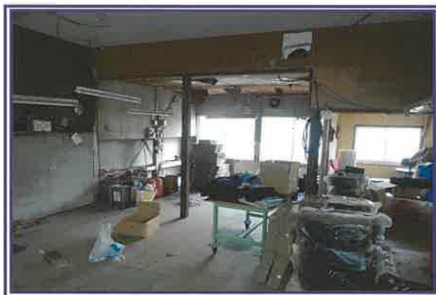
作業所(北側) (物件4主である建物)
