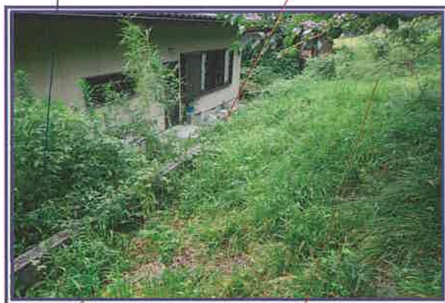
北東側隣地 (476-1)付近
