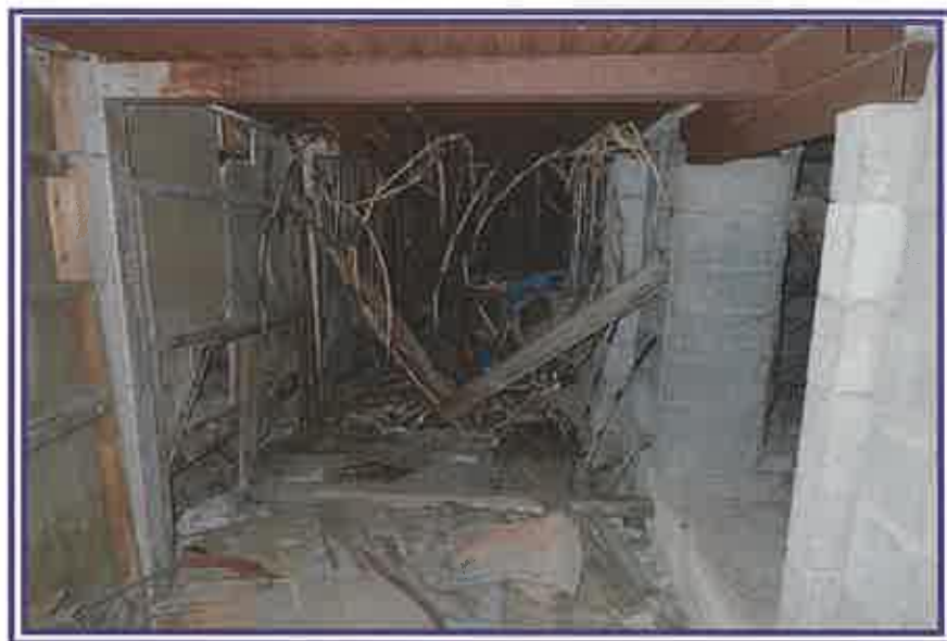
通路部分 (高床式構築物)
