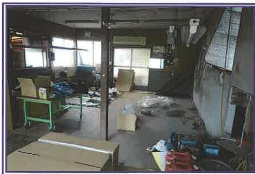
作業所(北側) (物件4主である建物)
