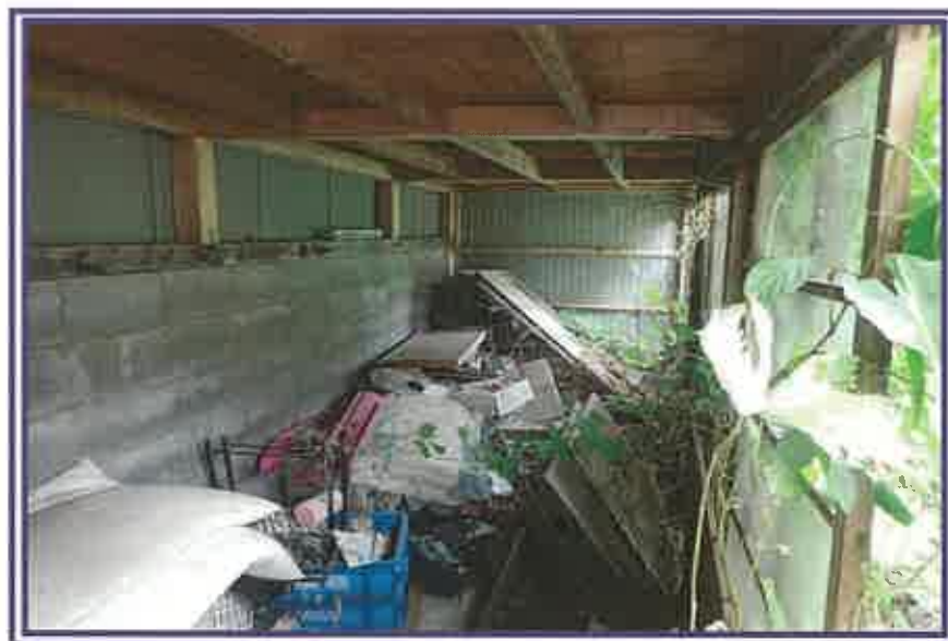
倉庫1階 (物件2未登記附属建物)
