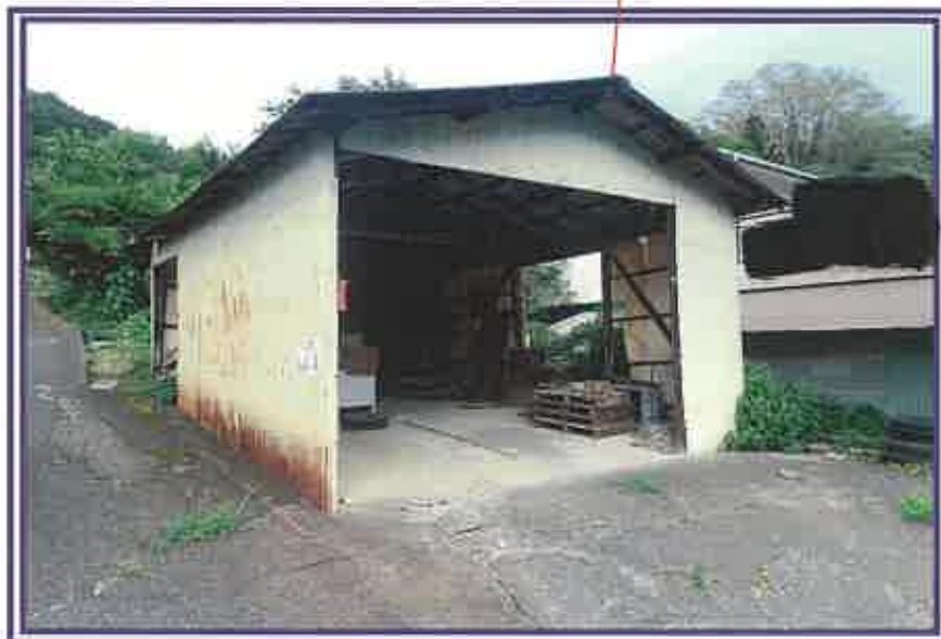
物件4附属建物 符号1(車庫)
