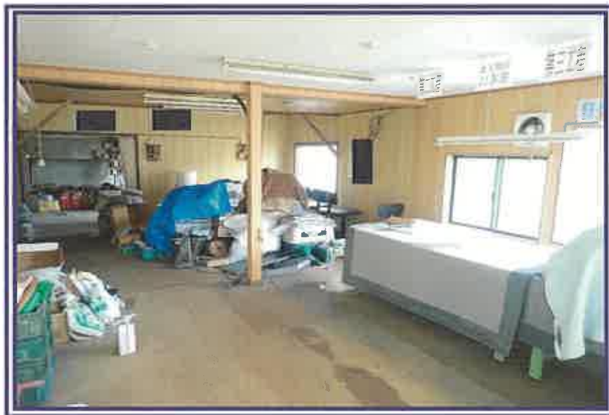
作業所(南側) (物件4主である建物)
