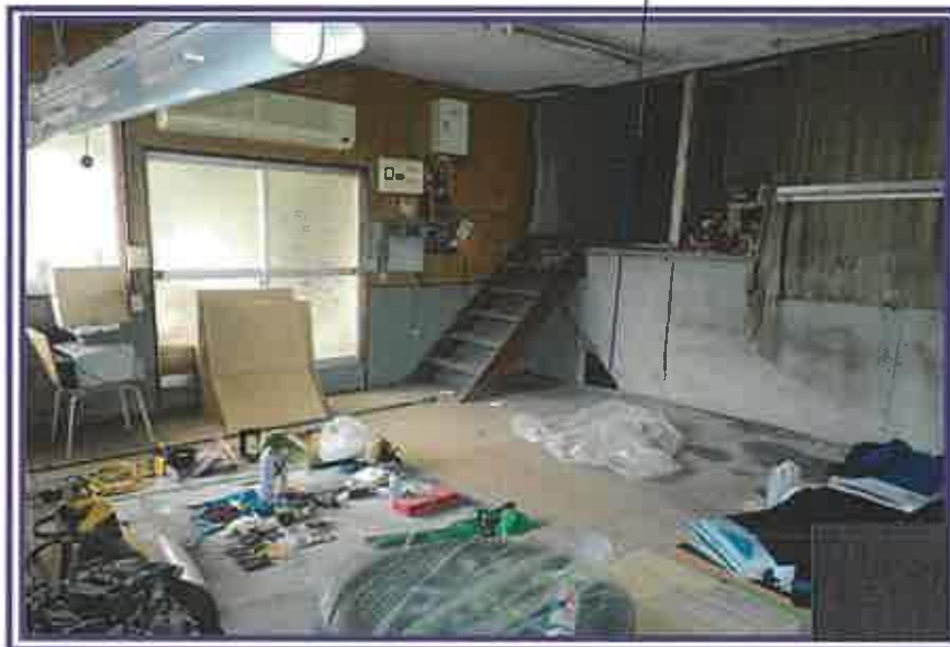
作業所(北側) (物件4主である建物)
