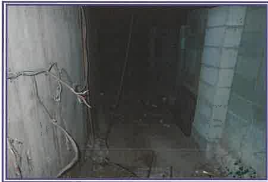
通路部分 (高床式構築物)
