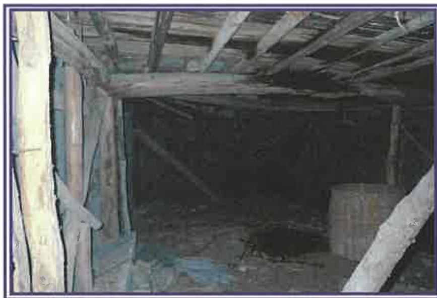
保管庫 (高床式構築物)
