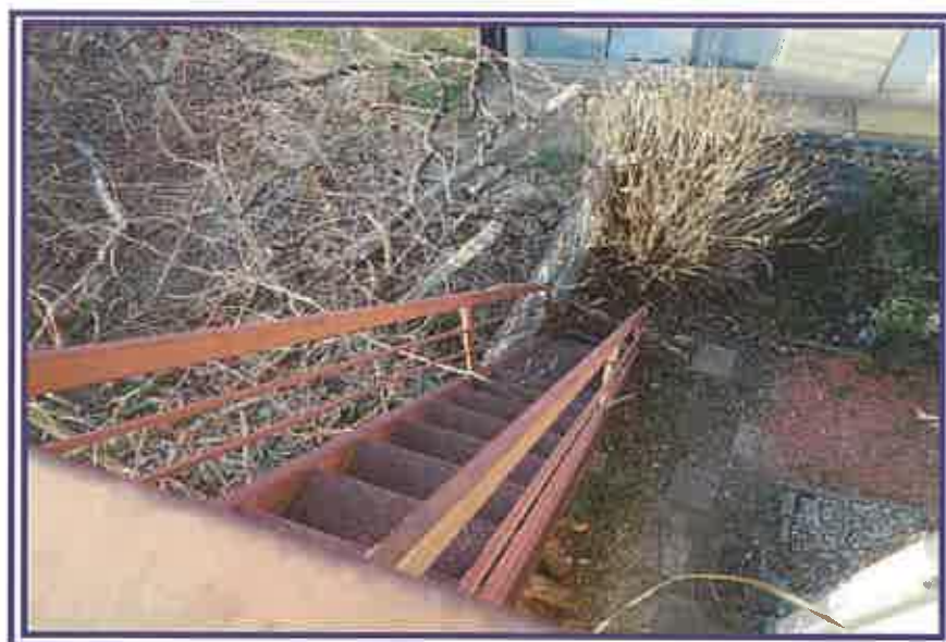
西側増築部分の2階から、外階段方向を撮影したもの
