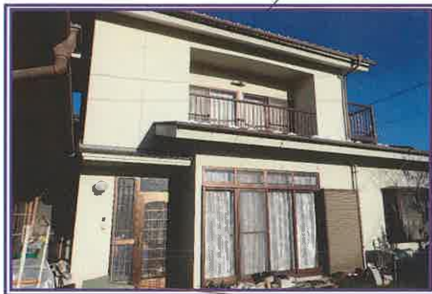
南側増築部分
