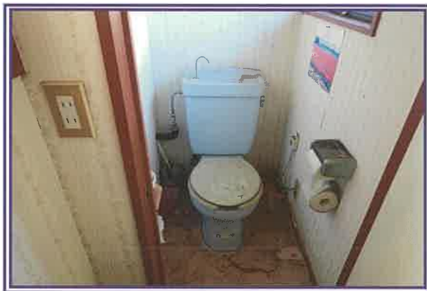
トイレ(西側増築部分の2階)
