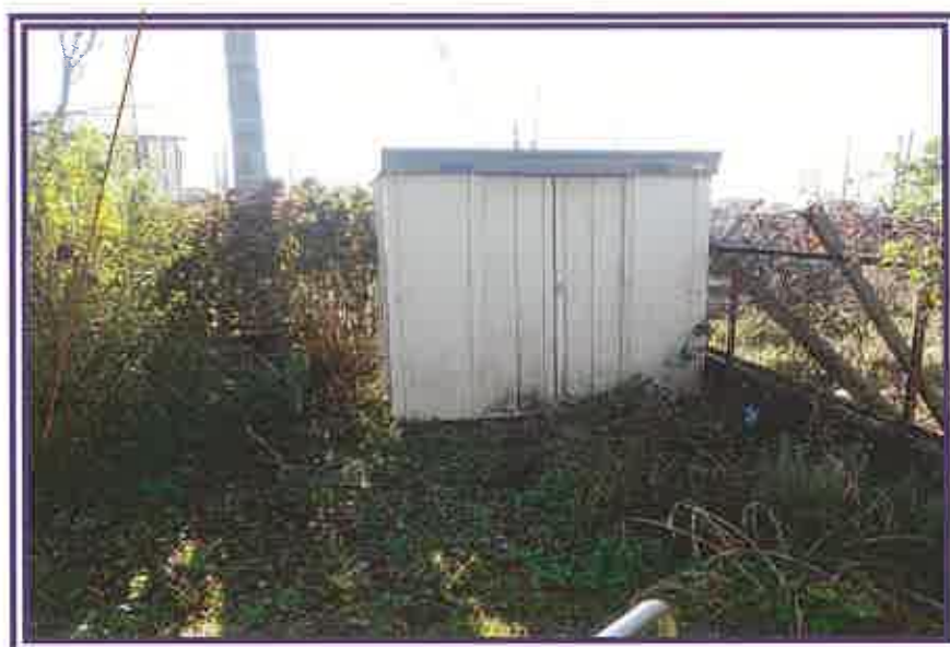
物置及びその周辺を撮影したもの
