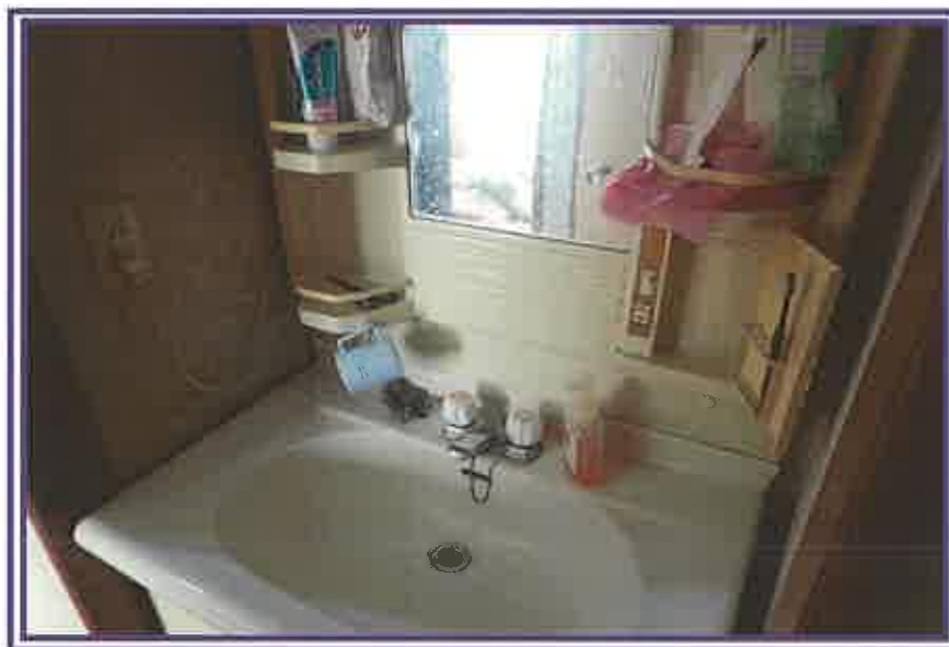
洗面台(南側増築部分の2階)
