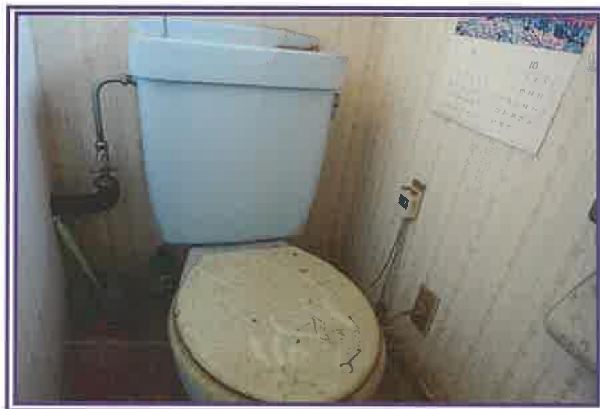
トイレ(西側増築部分の2階)
