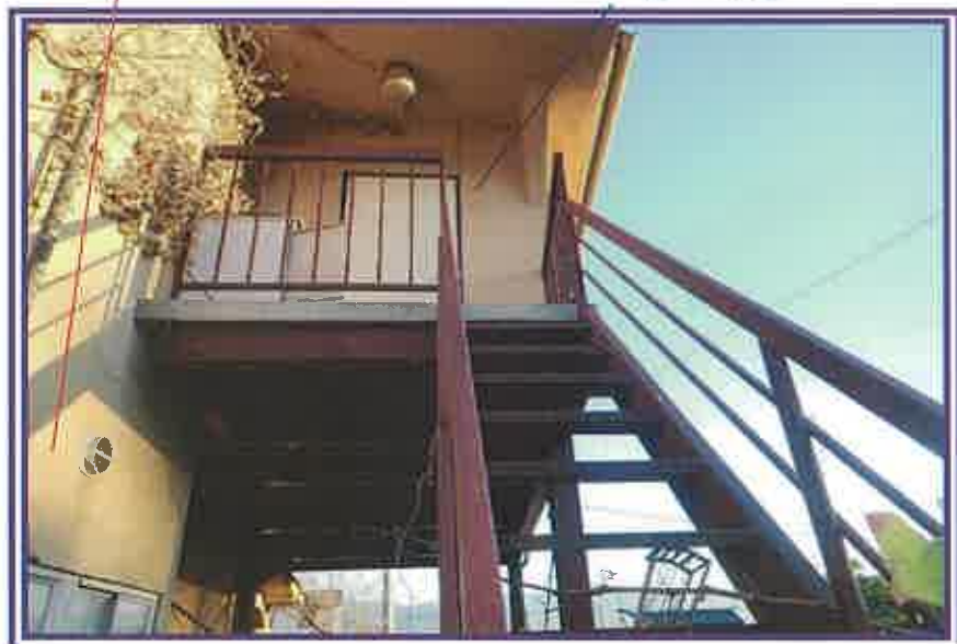
西側増築部分 (2階のみ増築)
