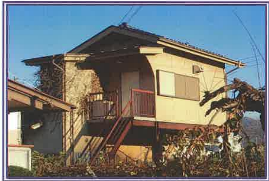
西側増築部分及びその周辺を撮影したもの
