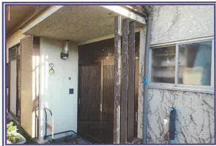
玄関付近を撮影したもの
