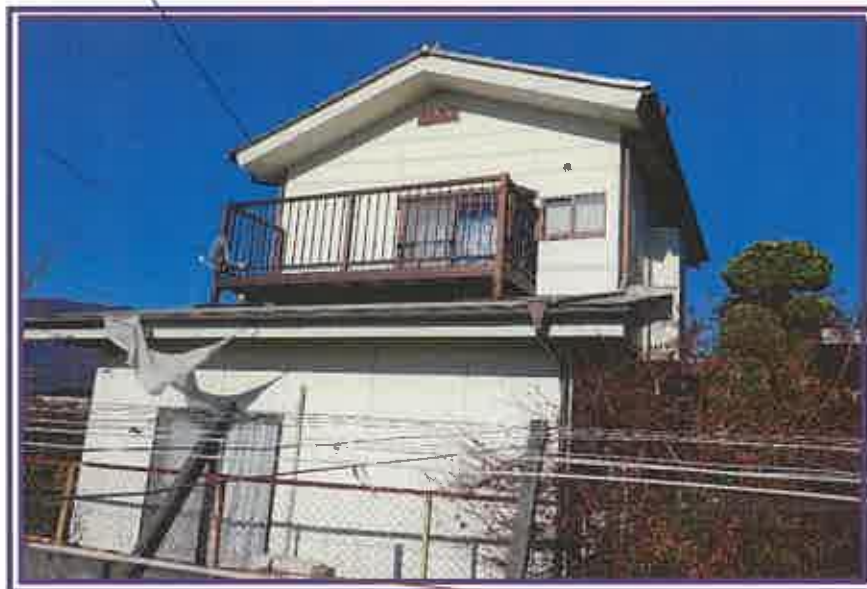
南側増築部分
