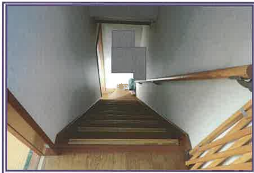
2階から階段方向を撮影したもの(南側増築部分)
