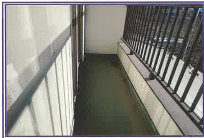
ベランダ(南側増築部分の2階)
