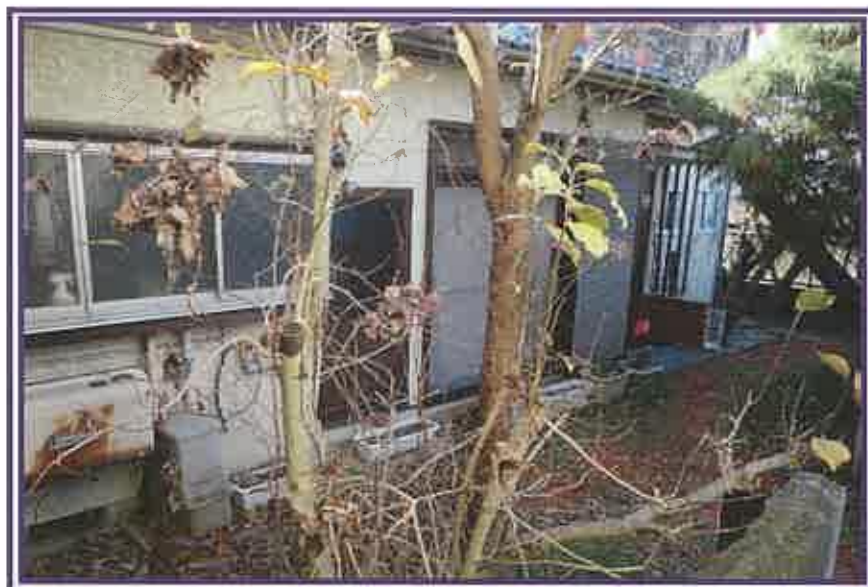
本件建物の台所付近を撮影したもの
