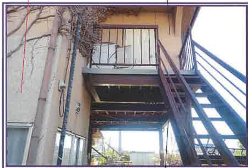
西側増築部分 (2階のみ増築)
