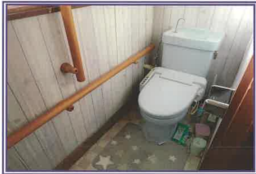
トイレ(1階西側部分)
