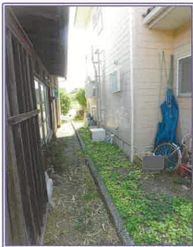
北側隣家との近接状況
