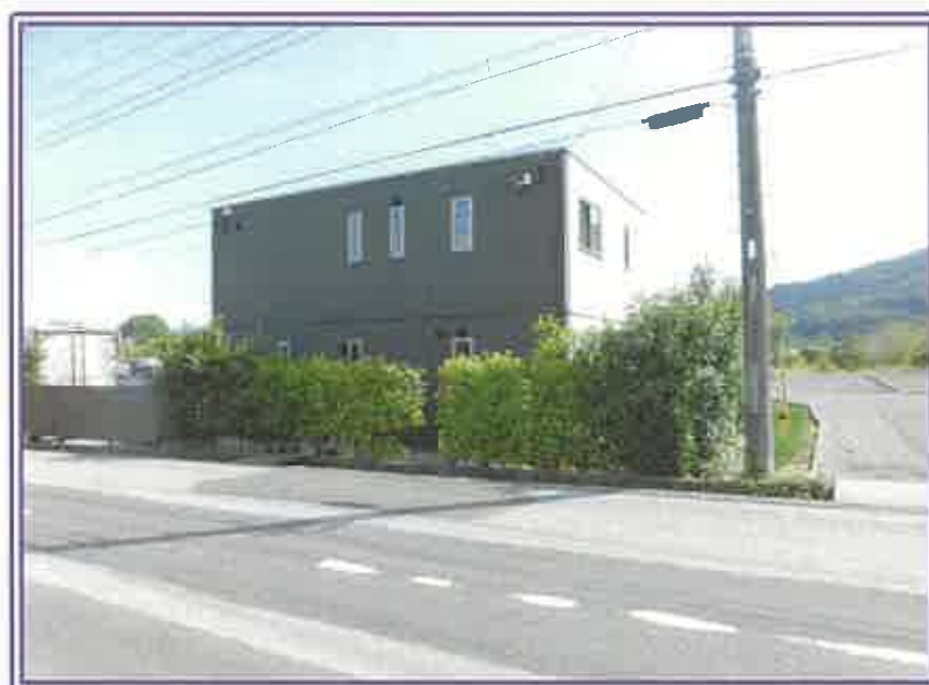
本件建物の道路側遠景
