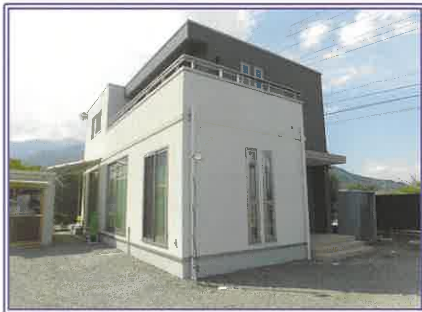
本件建物の正面近景
