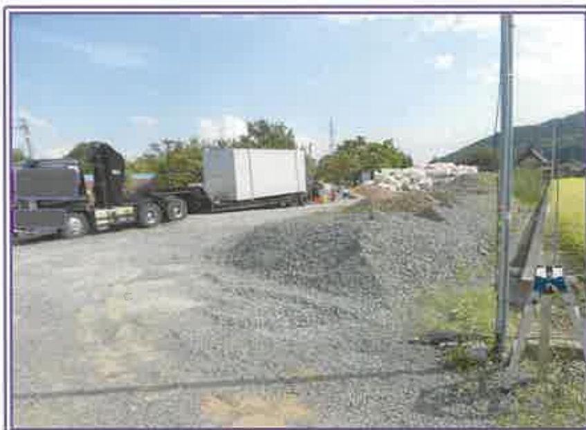
広大な土地(536)の状況(奥(右側)は廃棄物置場)
