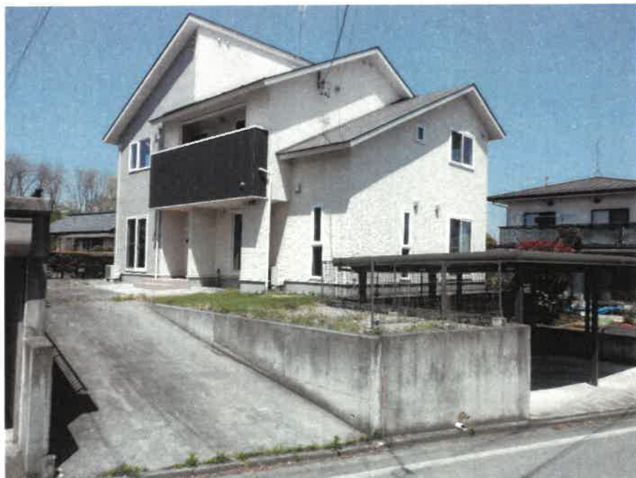
南東方から撮影
