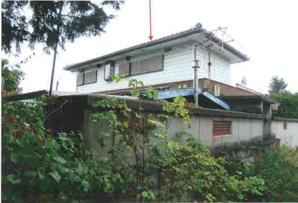
物件3主である建物
