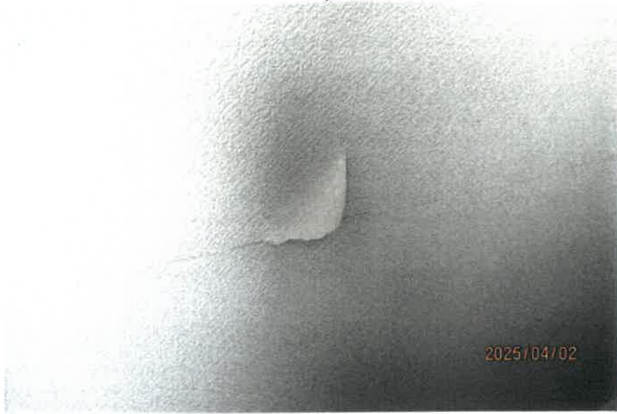
クロスが剥離している状況
