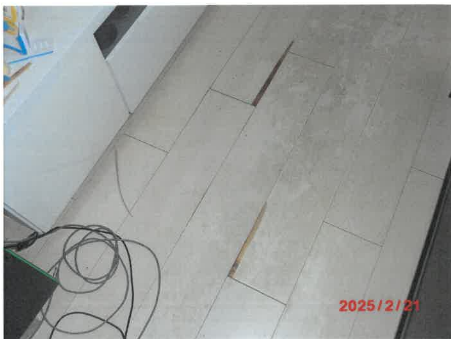
床損傷部分
