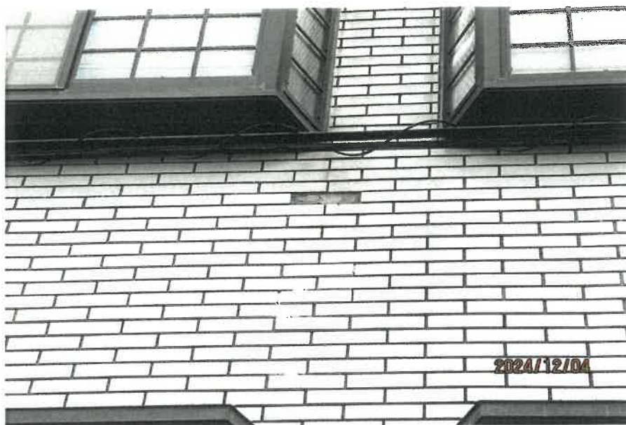
外壁タイルが剥離している状況
