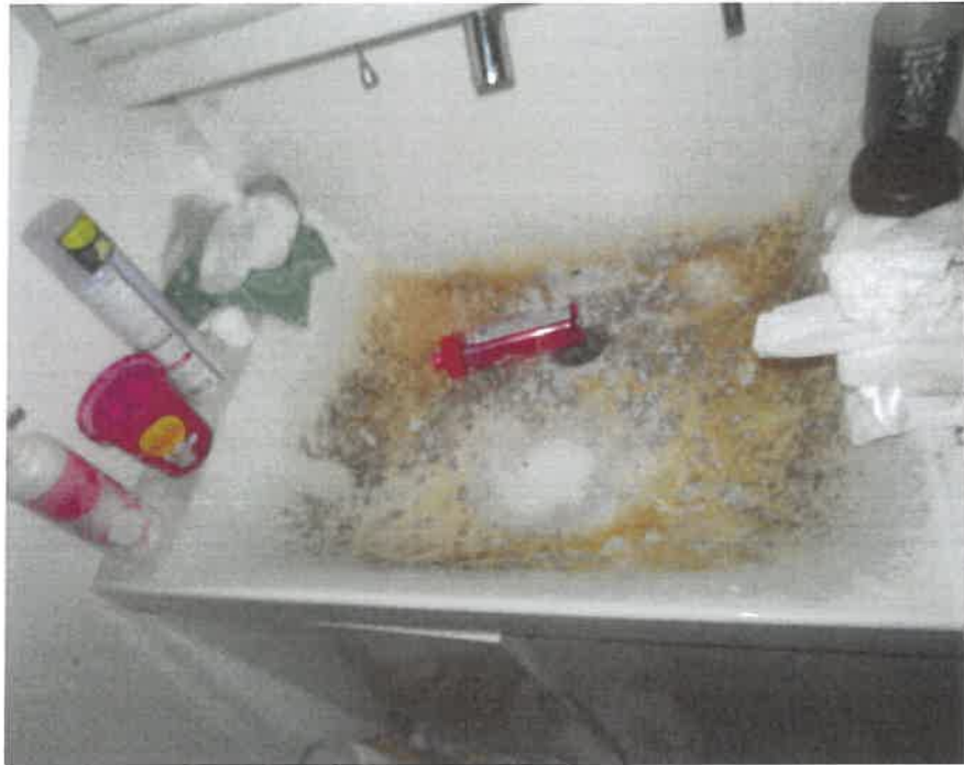
洗面台の汚損
