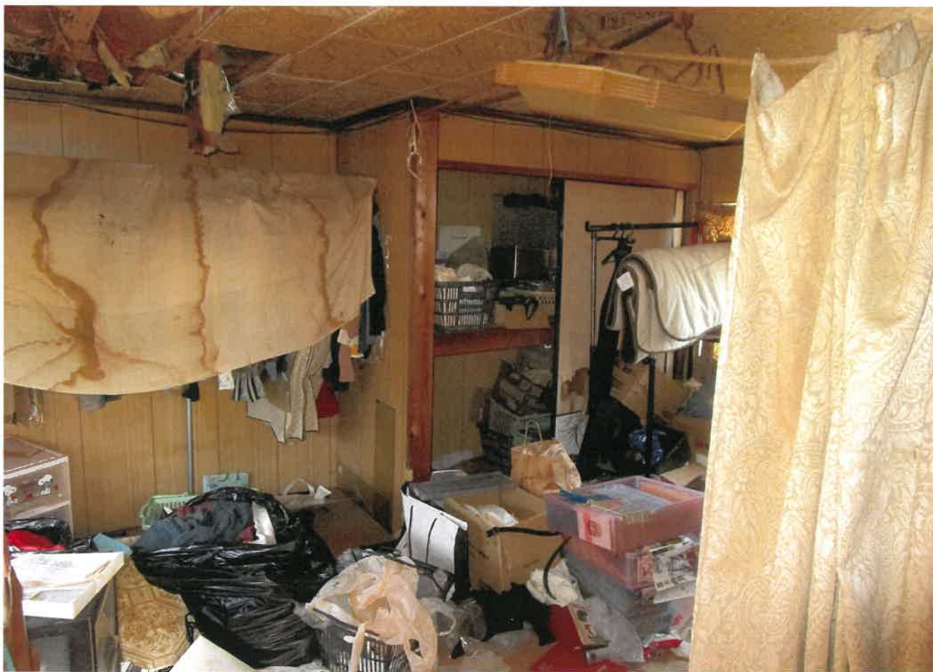
18 附属建物②の2階内部
