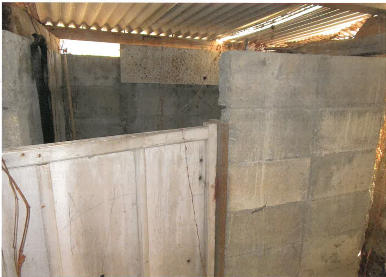
20 附属建物③の東側
