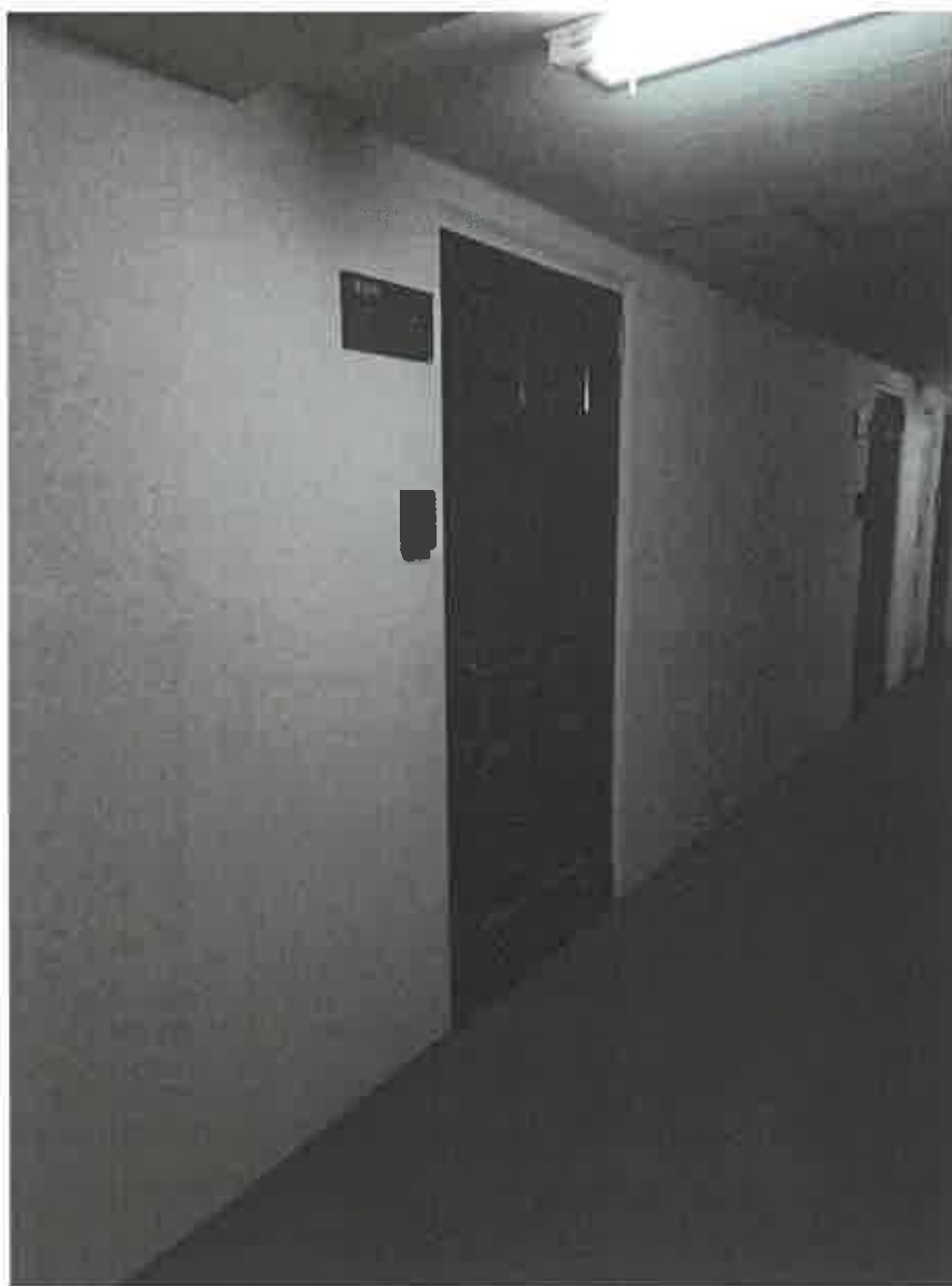
専有部分玄関付近
