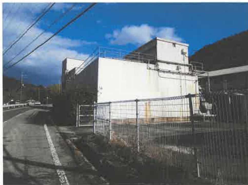
工作物（排水処理設備）
