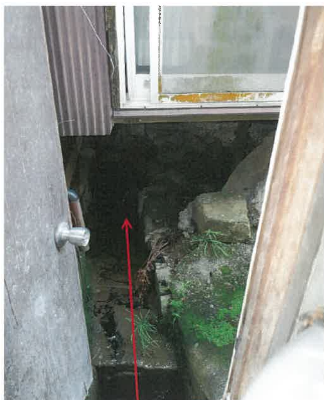
北側隣地からの水路
