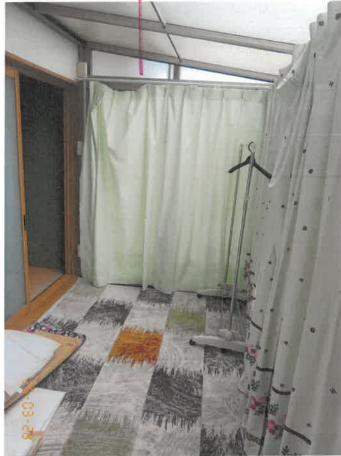
サンルーム(増築部分)
